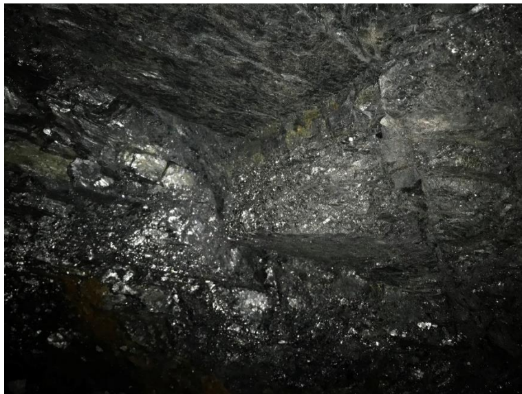
Figura 12: Humedad en el macizo rocoso en las labores Séptima Maravilla II.
