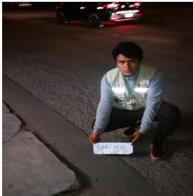
Fotografía N°23: Avenida Indoamérica - Parcheo
