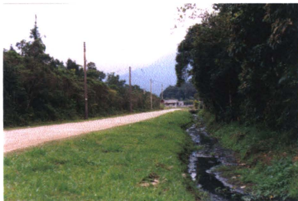
FOTOGRAFIA 11 – VALA A CÉU ABERTO EM RUA SEM SISTEMA DE DRENAGEM, SEM PAVIMENTAÇÃO E SEM SISTEMA DE ESGOTOS SANITÁRIOS NO JD. VISTA LINDA, BERTIOGA.
