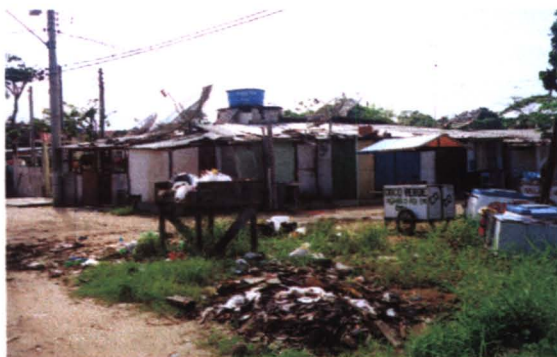
FOTOGRAFIA 18 - VISTA DA FAVELA DO INDAIAZINHO. PROBLEMAS HABITACIONAIS, AMBIENTAIS E SANITÁRIOS
