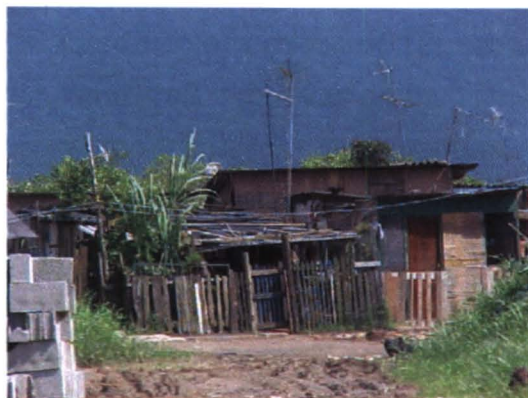
Fotografia 4 - Moradias precárias levantadas em Bertioga
