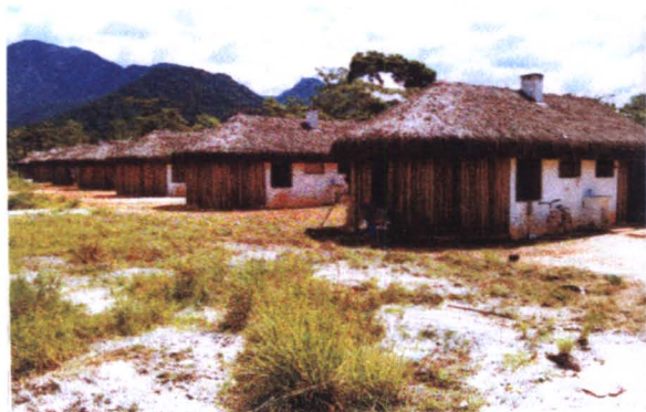
FOTOGRAFIA 9 - HABITAÇÃO INDÍGENA NA ALDEIA DO RIO SILVEIRAS DA ETNIA GUARANI (EXECUÇÃO DA CDHU)
