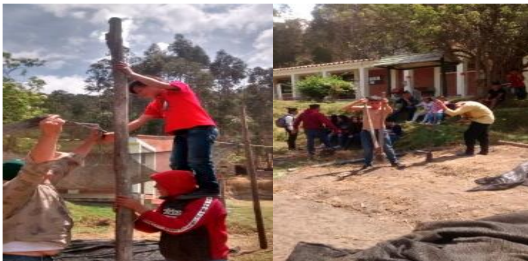
Ilustración 7 Instalación de polisombra
