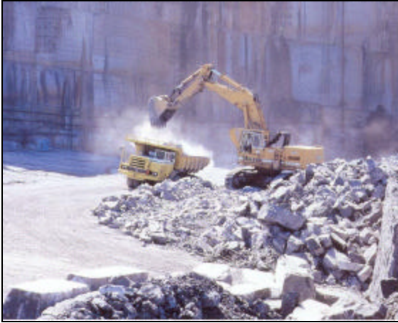
Foto 18: Het verwijderen van het losse materiaal.
