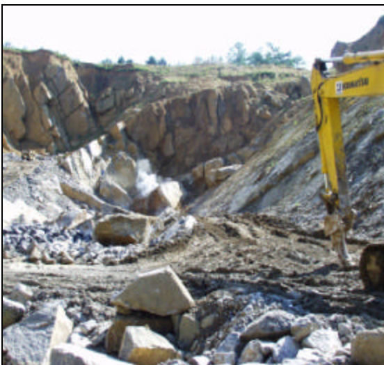
Foto 16: Explosie in de groeve Flay-co (foto V. CNUDE).
