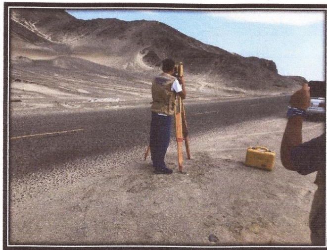
FOTO N°05: En la fotografía se muestra el desgaste a la abrasión que presenta la CARRETERA.
