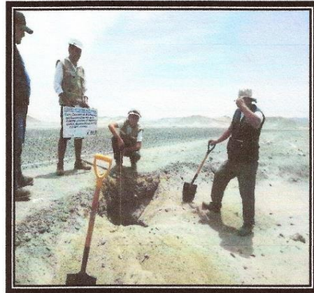
FOTOS N° 13,14: Excavación manual de Calicata N° 04
