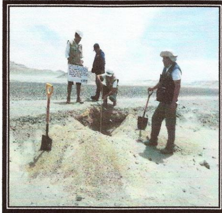
FOTOS N° 13,14: Excavación manual de Calicata N° 04
