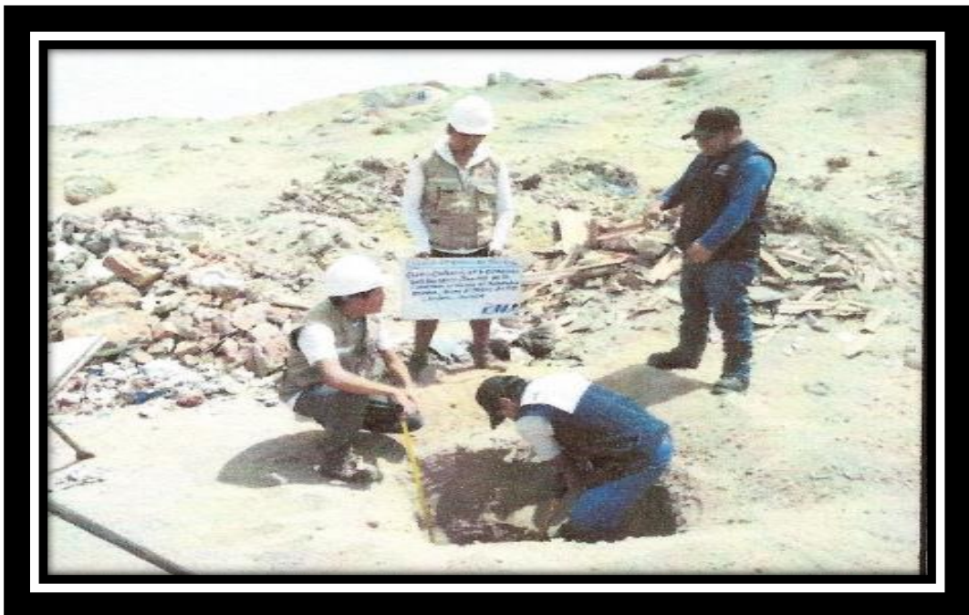
Excavación de calicata para extracción de muestras
