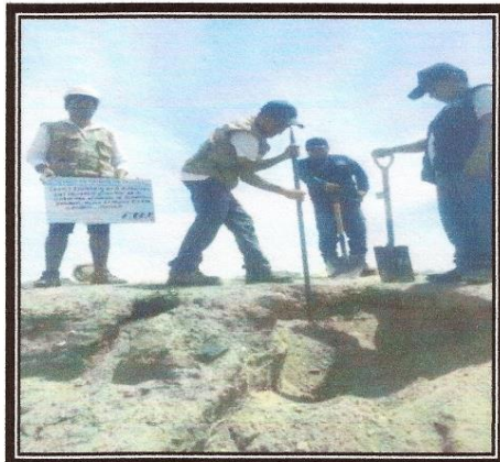
FOTOS N° 07,08: Excavación manual de Calicata N° 02
