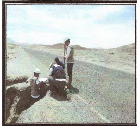
FOTOS N° 09,10: Excavación manual de Calicata N° 03
