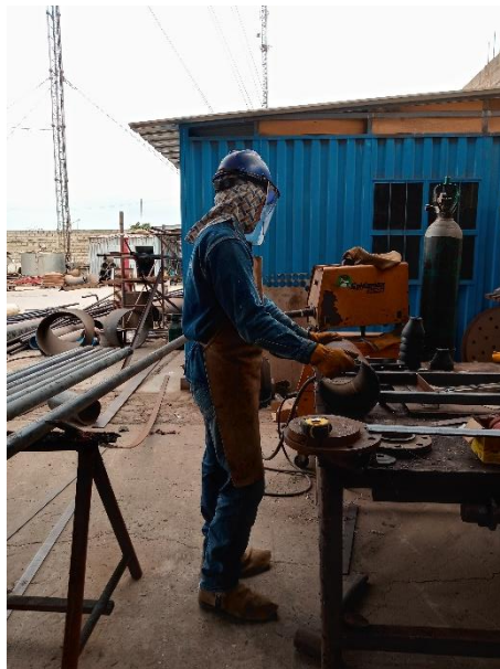
Figura 104. Levantamiento de destino: esmerilado T1.
