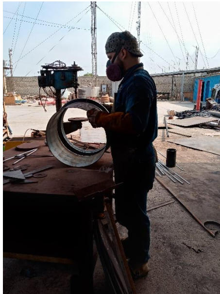
Figura 66. Levantamiento de destino: soldeo T1.
