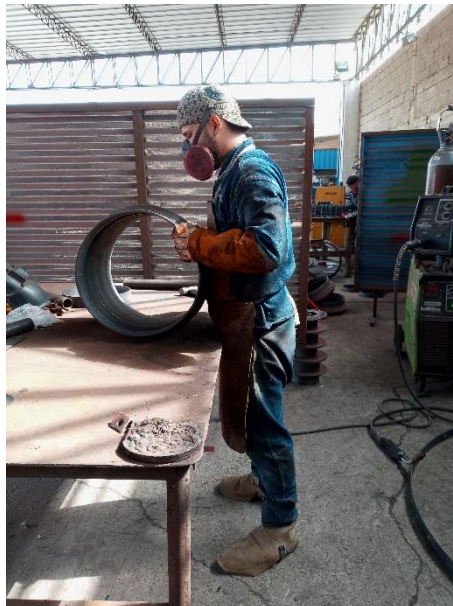
Figura 108. Levantamiento de destino: soldeo T1.
