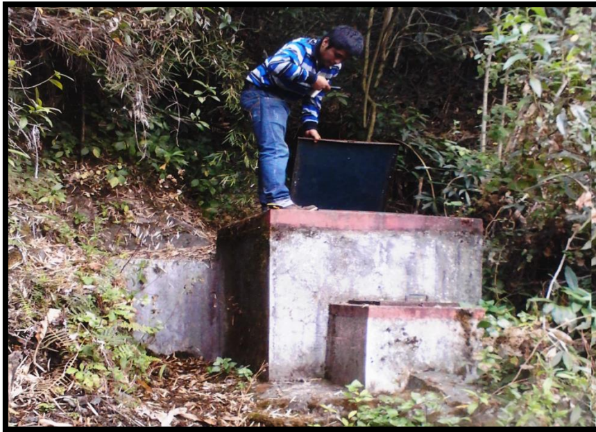
IMAGEN 1: ESTADO ACTUAL DE LA CAPTACIÓN
