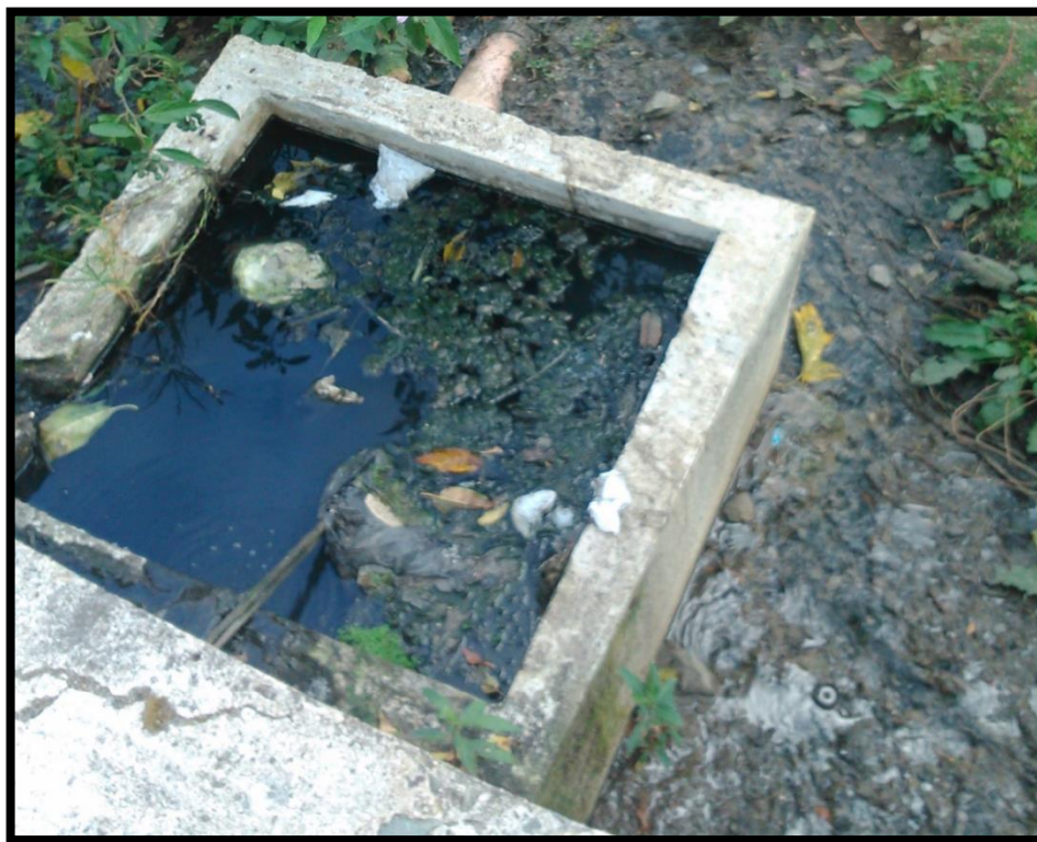
IMAGEN 2: ESTADO ACTUAL DE ESTRUCTURA EXISTENTE I
