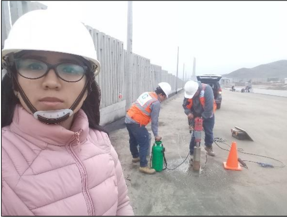
Foto 23: Control de proceso. Extracción de briqueta en carpeta
