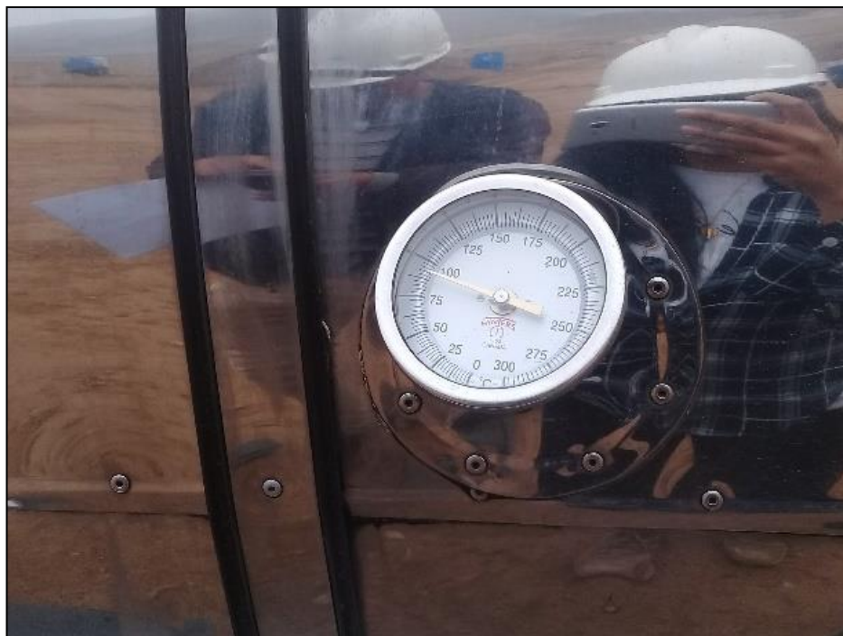
Foto 20: Proceso de pavimentación. Temperatura de Imprimación
