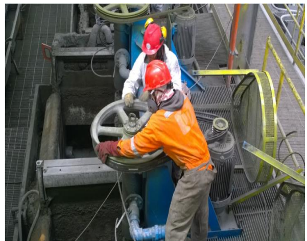
✓ Falta de mantenimiento Predictivo
