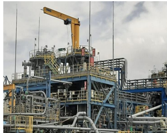
✓ Uso de puente grúa para desmontaje
