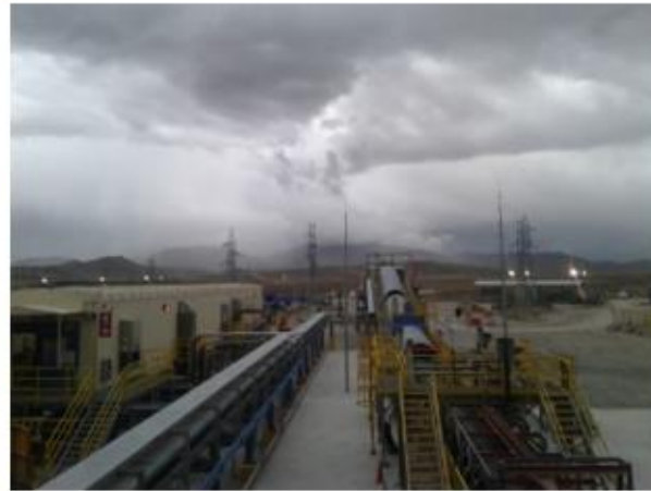
✓ Contratiempos debido a Tormentas Eléctricas
