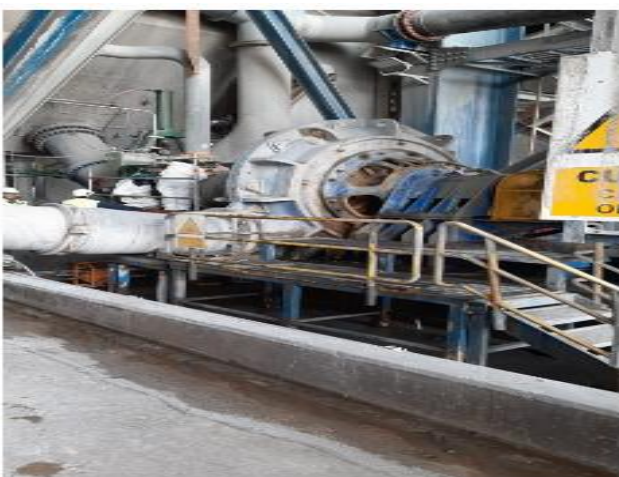
✓ Desmontaje de Celda de flotación
