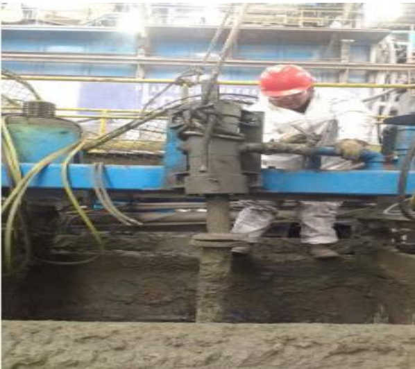
✓ Falta de Técnicas de medición
