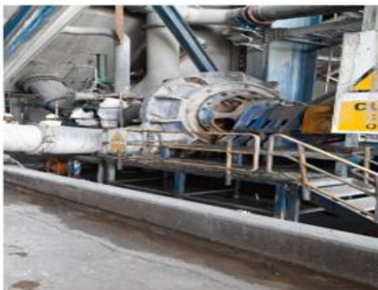
✓ Desmontaje de Celda de flotación
