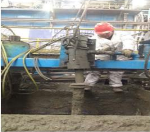
✓ Falta de Técnicas de medición
