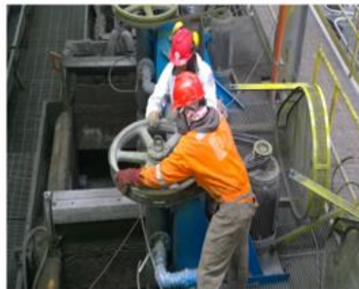
✓ Falta de mantenimiento Predictivo
