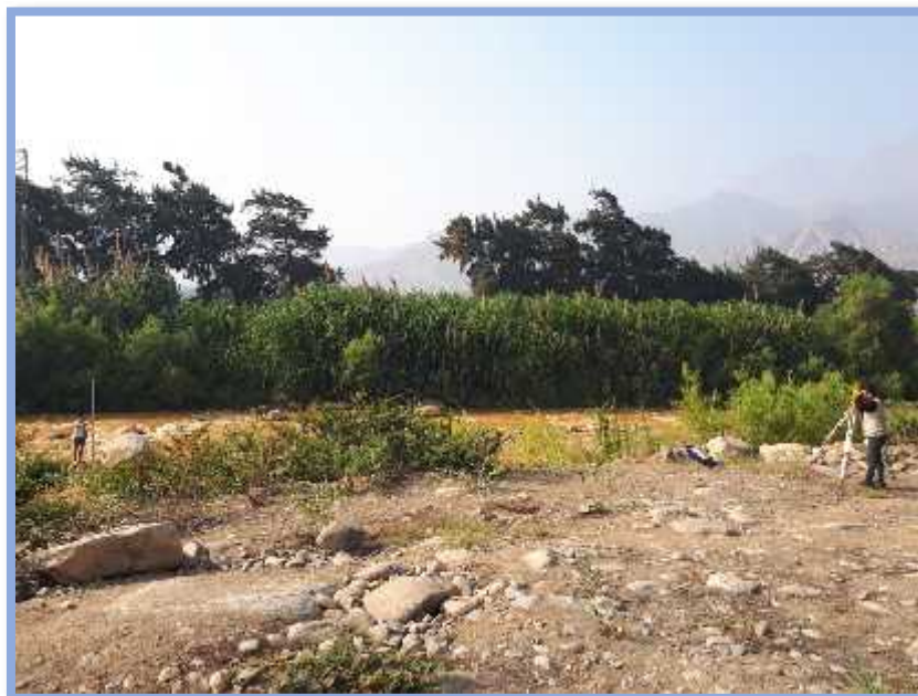
Descripción: tomando punto para el perfil longitudinal cerca al Punto crítico N° 02
