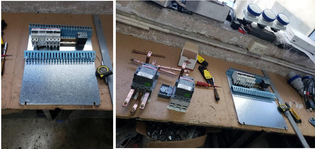
Figura 24 - Materiales completos Fuente: Elaboración propia
