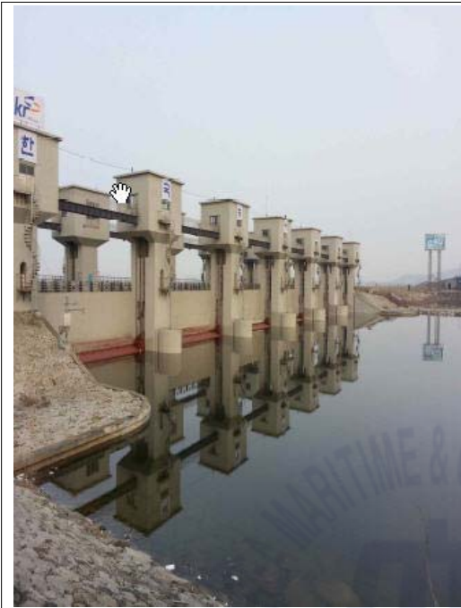
(삼교호 배수갑문 전경)
