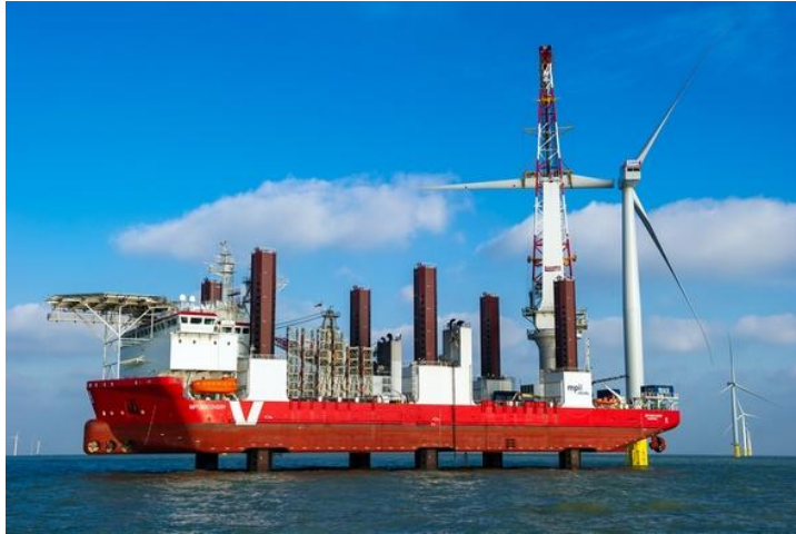
Fig. 22 해상풍력 설비 설치공사
