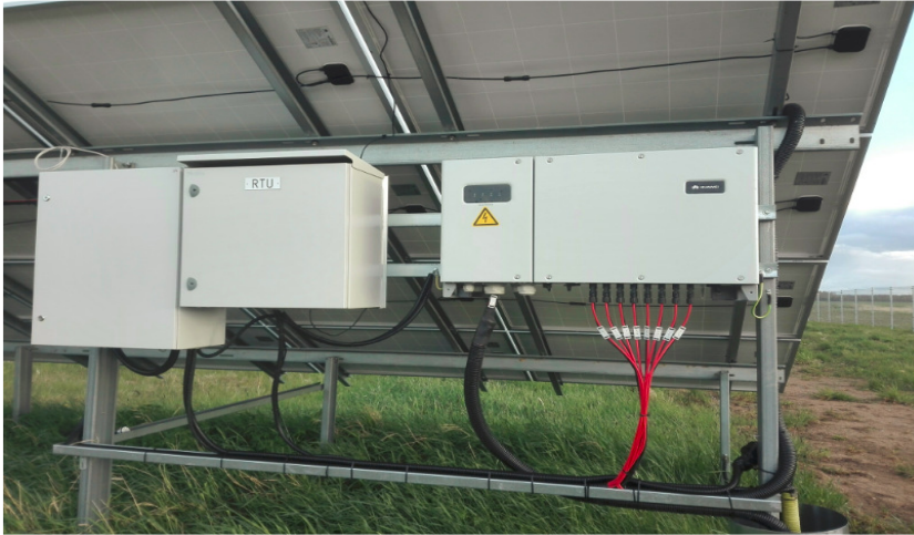
Joonis 3.5. Päikesepargi inverteri kilp.
