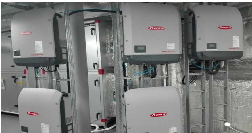
Joonis 3.3. Fronius inverterid
