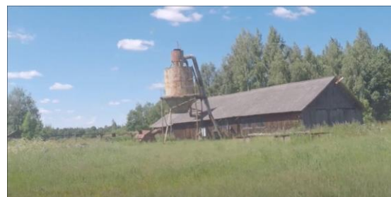
Photo nr 6. Kolkhoz „Ühenduse“ later Luunja sovkhos old saw mill
