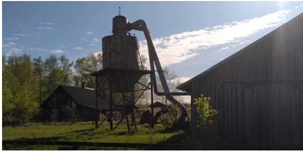
Photo nr 53. Kolkhoz „Ühenduse“, later Luunja sovkhos old saw mill (3)
