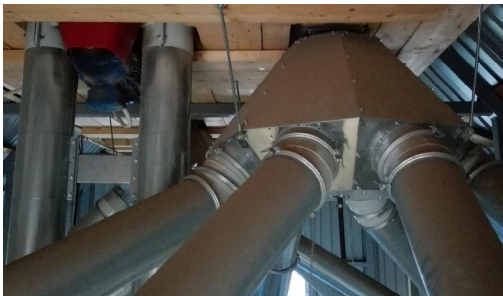
Joonis 1. Antti 8 – väljundiga pöördjaotur Figure 1. Antti 8 – way rotary distributor
