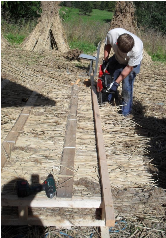
Joonis 3.60. Seinapaneeli valmistamine maas ja mõõtulõikamine (foto: J. Miljan)
