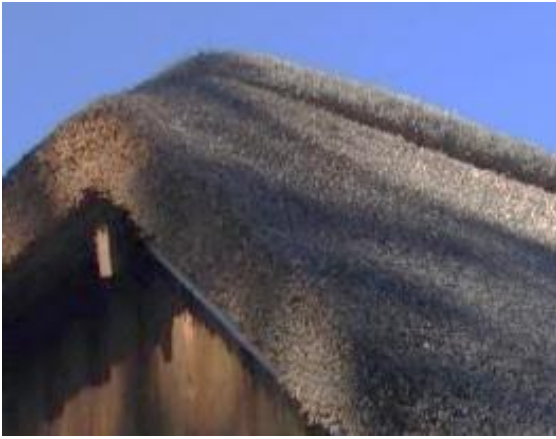
Joonis 3.17. Eesti jaoks ebatraditsiooniline kanarbikuga kaetud katusehari ja räästajoon, mis ei ole katusel olevate rookõrte suunaga risti (foto: T. Pitkänen)
