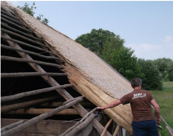
Joonis 3.6. Rookihi paigaldamine paanide-na vanadele roovidele (foto: J. Miljan)
