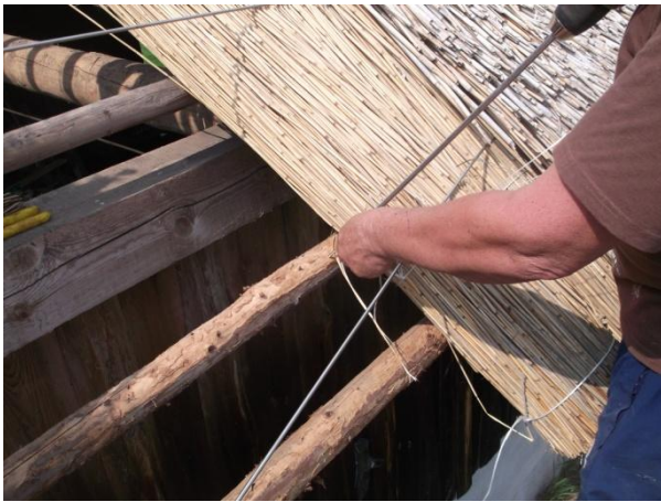
Joonis 3.8. Sidumistraadi kinnitamine roovi külge kruviga (foto: J. Miljan)
