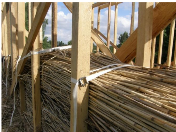
Joonis 3.58. Kokku pressitud pilliroo kinnitamine plastiklintidega karkassipostide külge (foto: J. Miljan)
