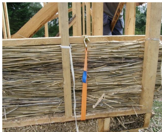
Joonis 3.57. Pilliroovihkude esimese kihi kokku pressimine koormarihmu kasutades (foto: J. Miljan)
