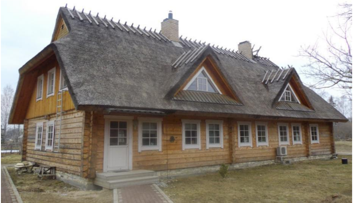
Joonis 3.13. Harjamalkadega kinnitatud katusehari Saaremaal (foto: S. Sõber)
