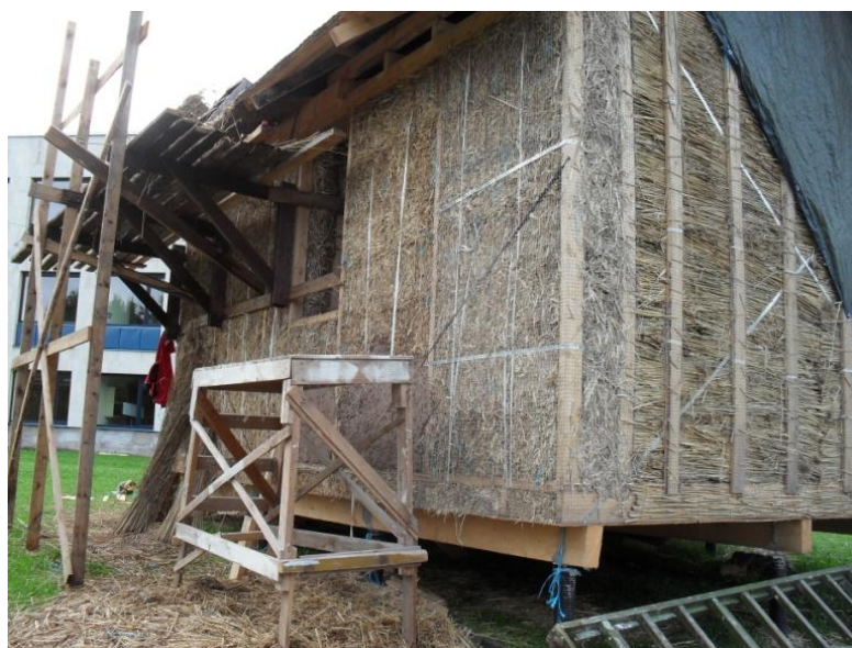
Joonis 3. 63. Presendiga kaetud seiniosa ja karkassena jäigastamiseks diagonaalselt paigaldatud metallilindid (foto: J. Miljan)
