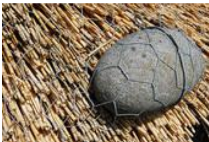
Joonis 3.15. Katuseroo kinnitamine tuulisel alal (foto: Photosearch 2013:88)
