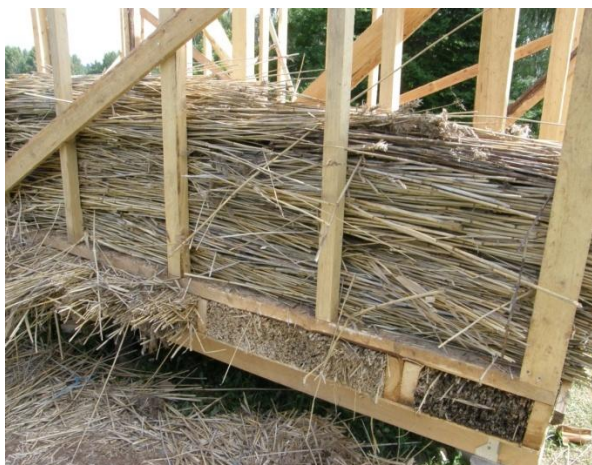
Joonis 3.56. Lahtine pilliroog horisontaalselt karkassipostide vahel (foto: J. Miljan)
