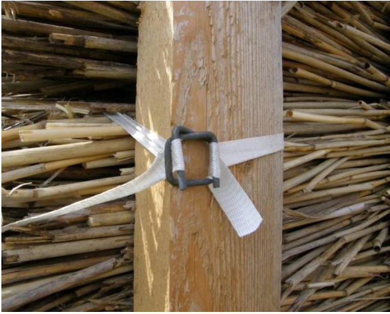
Joonis 4.7. Koormarihmadega kokkupressitud roo kinnitamine karkassiposti külge (foto: J. Miljan)
