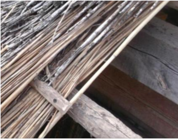
Joonis 3.4. Vana vahetatav roogkatus ja puidust korralatt (foto: J. Miljan)
