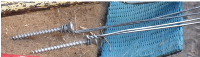
Joonis 3.3. Traadiga kruvid korralati ja kahlude kinnitamiseks (foto: J. Miljan)
