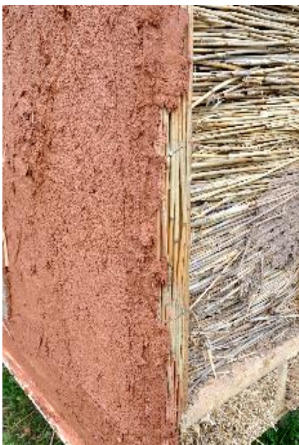
Joonis 3.62. Esimese kihi savikrohviga kaetud pilliroost sein (foto: J. Miljan)
