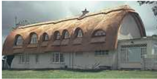
Joonis 3.23. Eenduv hari ( block ridge ) (foto: Thatchco ... 2013)
