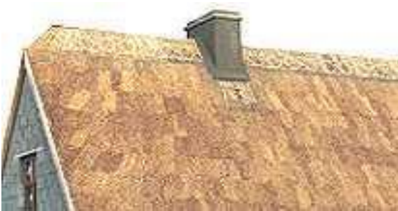
Joonis 3.22. Lame hari ( flush ridge ) (foto: Thatchco ... 2013)
