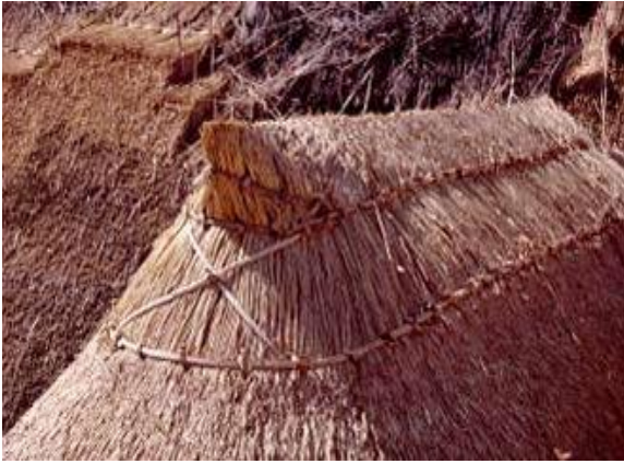
Joonis 3.21. Erinevad harja kinnitamise viisid Inglismaalt ja kaunistusega hari vasakpoolsel fotol (fotod: Building Conservation ... 2013)
