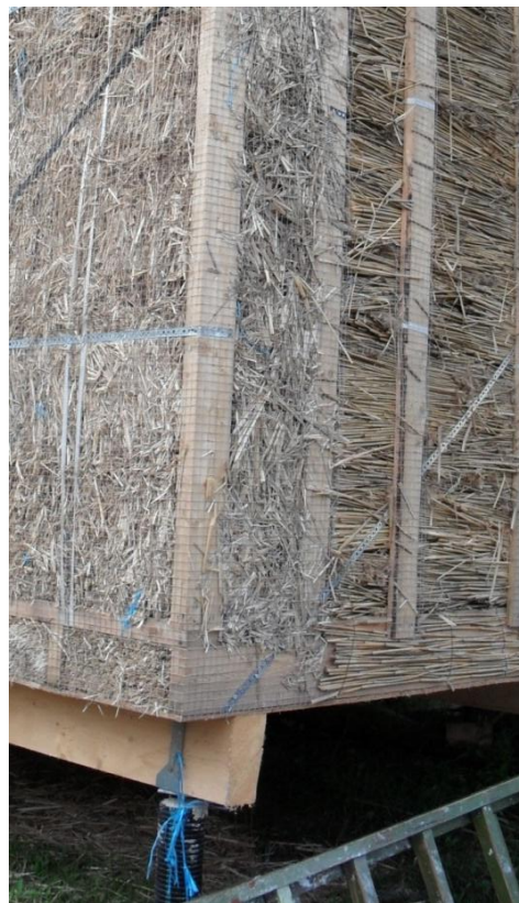
Joonis 3.61. Võrguga kaetud seinapuitosad ja metall-lintidega jäigastatud sein enne krohvimist (foto: J. Miljan)
