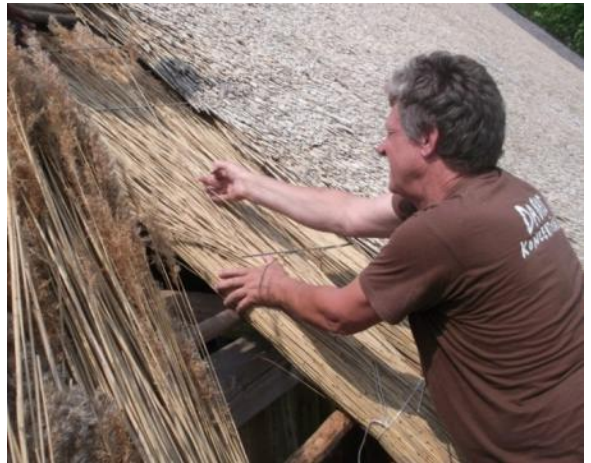
Joonis 3.7. Kahlude paigaldamine metallvardast korralattide alla (foto: J. Miljan)
