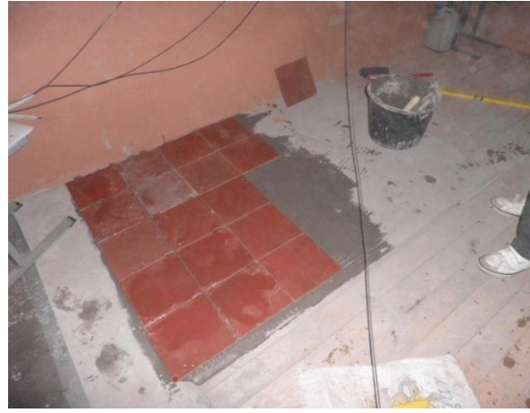
Joonis 4.8. Saviplaatpõranda ehitus (foto: J. Miljan)
