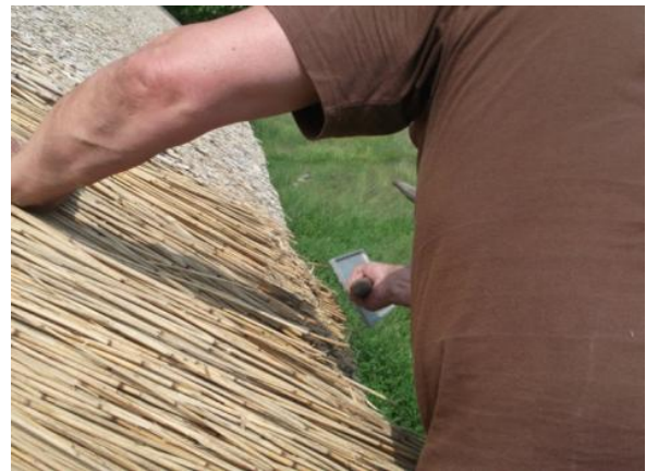
Joonis 3.11. Katuseräästa tasaseks löömine käpa ehk lasnaga (foto: J. Miljan)
