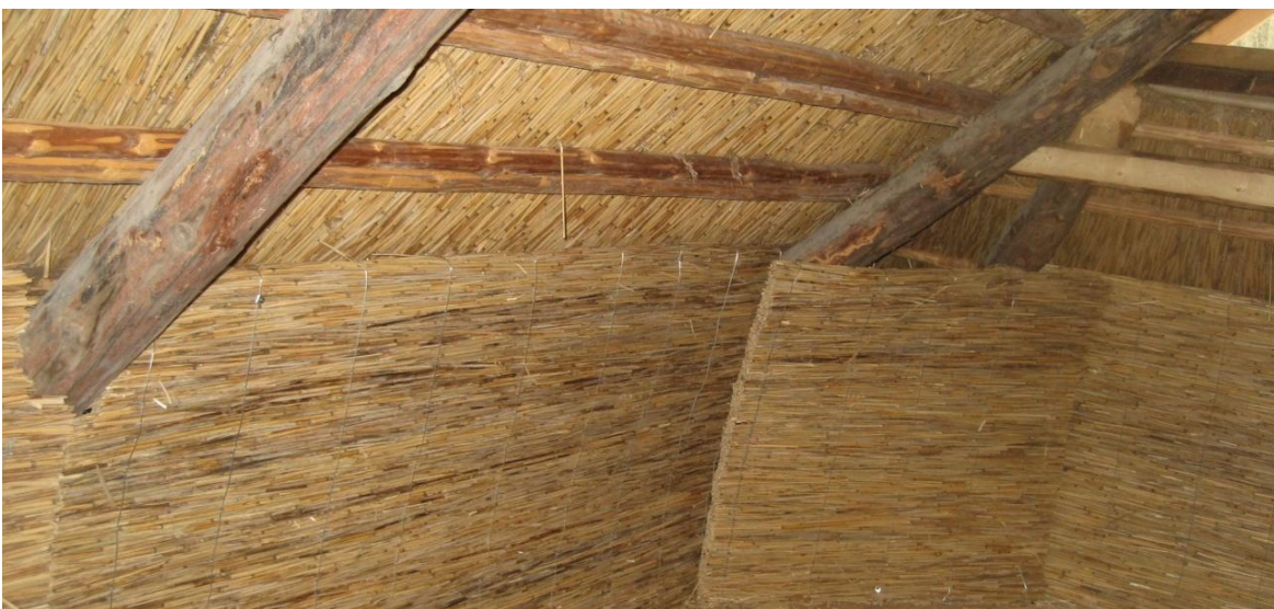
Joonis 3.54. Pillirooplaatidega kaetud räästatsoon elamu pööningul. Näha on ka roogkatuse alune pind (foto: K. Lilleste)
