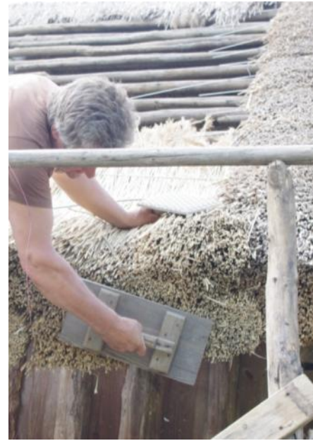
Joonis 3.2. Räästa silumine puidust (tammepuust) käpaga (foto: J. Miljan)
