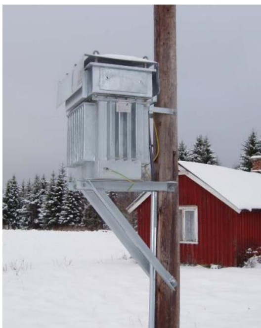
Joonis 5.5. Magtech pingetõstja paigaldatud puitmastile [21].
