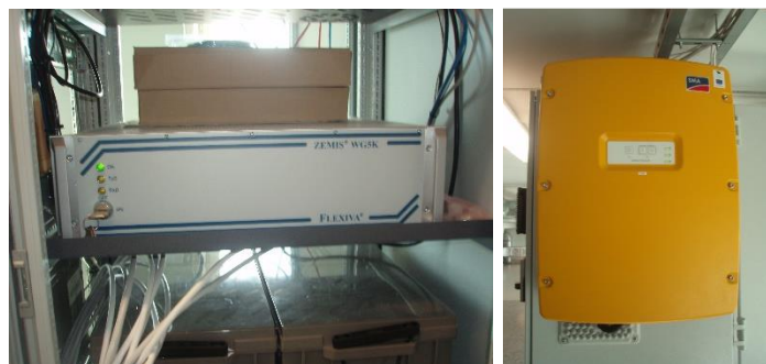
Joonis 3.9. Digitaalelektronika labori 230VAC/48VDC inverterid. Vasakul Flexiva ZEMIS WG5K juhtimiskilbis ja paremal Sunny Island 6.0 H juhtimiskilbi seinal
