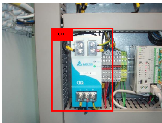
Joonis 3.11. Muunduri Delta Cliq Power Supply System 24 VDC asukoht juhtimiskilbis.
