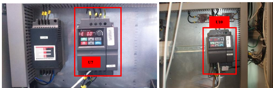
Joonis 3.10. Sagedusmuundurid vasakul DELTA VFD-EL037EL43A (U7) ja paremal DELTA VFD-EL002EL21A (U10)
