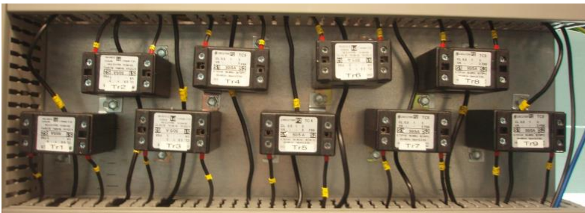
Joonis 3.14. Voolutrafode paigutus elektrikilbis
