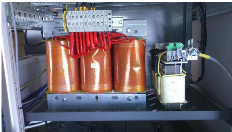
Joonis 3.7. Eraldustrafo T1 (vasakul) ja siinusefiltri L1 (vasakul) paiknemine juhtimiskilbis
