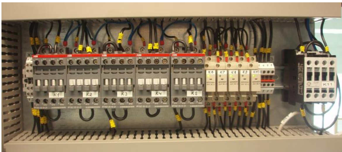
Joonis 3.20. Kontaktorite ja releede asetus juhtimiskilbiks. K1-K5, K11 on kontaktorid, K6-K10 releed ning V1 ja V2 releed
