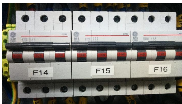
Joonis 3.21. Kaitselülitite astetus juhtimiskilbis esimese ukse taga üleval ning teise ukse taga asuvate kaitsete pilt all
