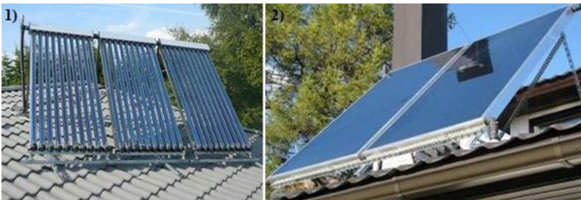
Joonis 3.1. 1) vaakumtorudega- ja 2) lame- ehk plaatkollektor [41]
