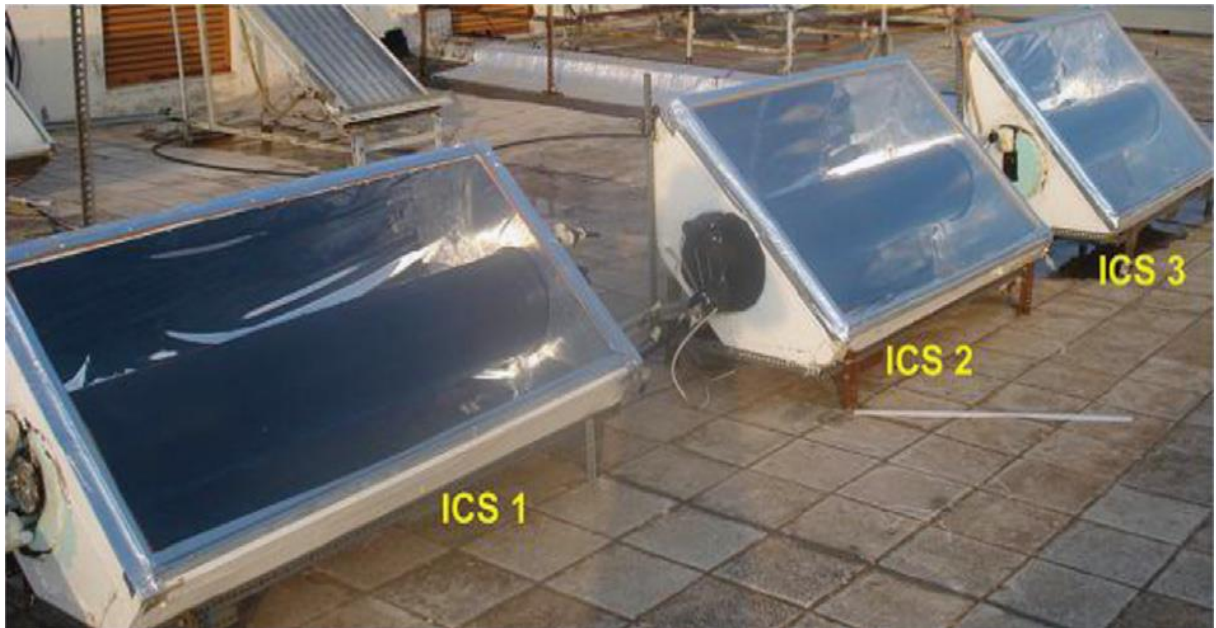
Joonis 14. Kollektoriga integreeritud akupaak (Singh jt 2015)
