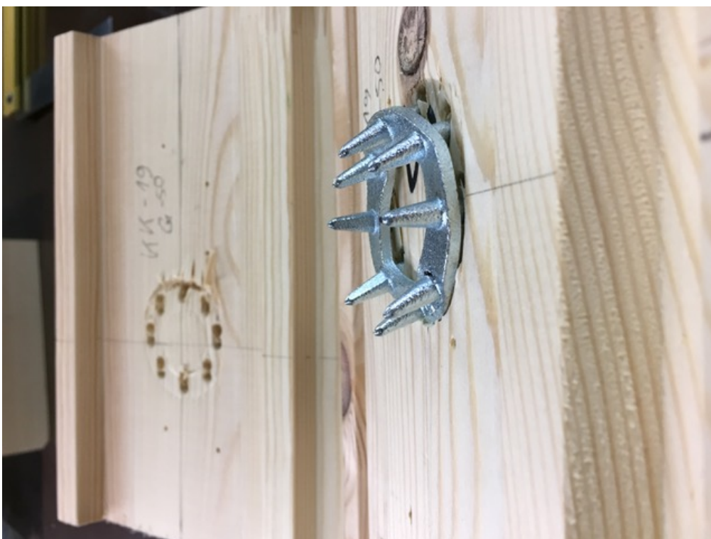
Joonis L4.17. Katsekeha KK19-C10/50 hammastüübli purunemine
