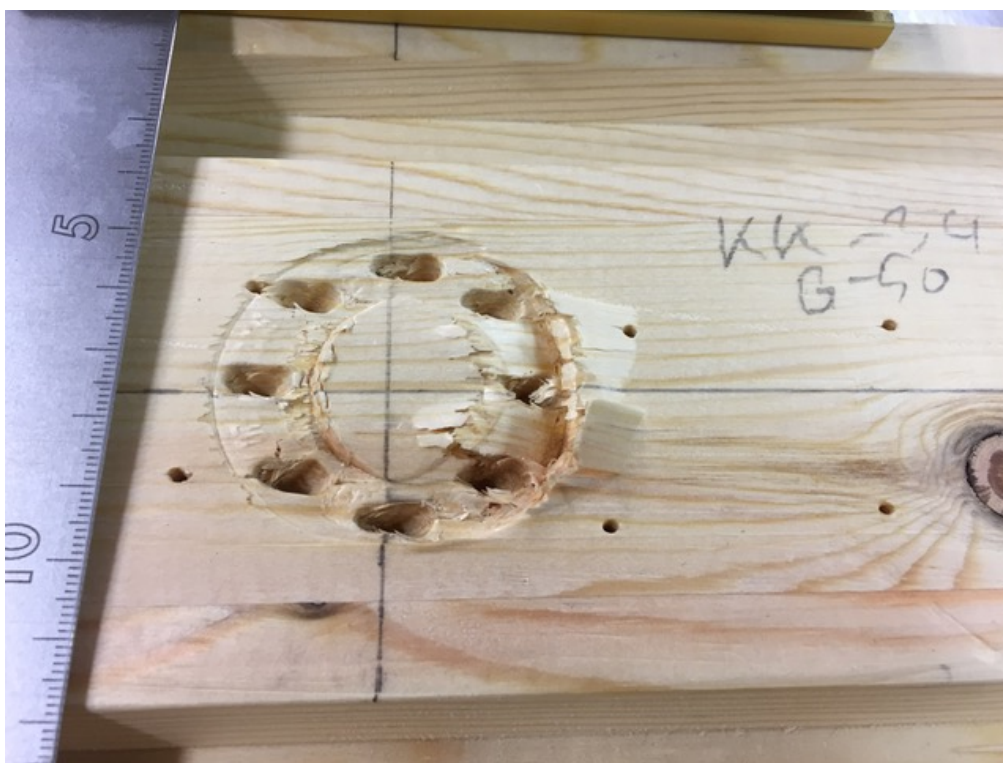
Joonis L6.8. Katsekehale KK34-2xC10/50 tekkinud hammastüübli muljumise jäljend
