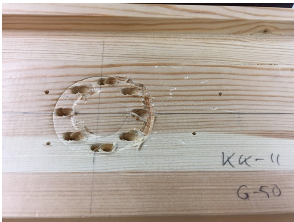
Joonis L4.2. Katsekehale KK10-C10/50 tekkinud hammastüübli jäljend
