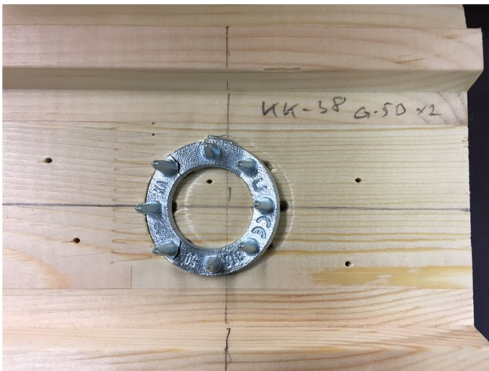
Joonis L6.15. Katsekeha KK38-2x10/50 hammastüübli purunemine
