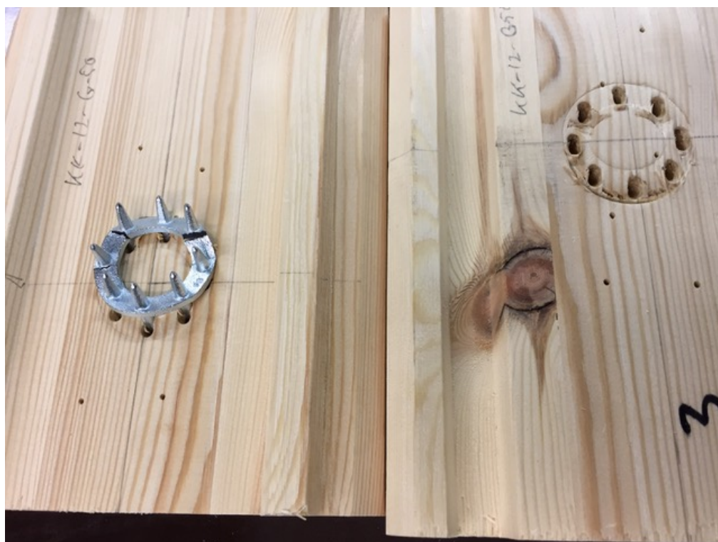
Joonis L4.5. Katsekehale KK12-C10/50 tekkinud hammastüübli jäljend
