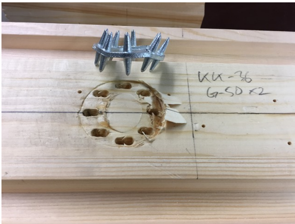
Joonis L6.12. Katsekehale KK36-2xC10/50 tekkinud hammastüübli muljumise jäljend ja deformeerunud hammastüübel
