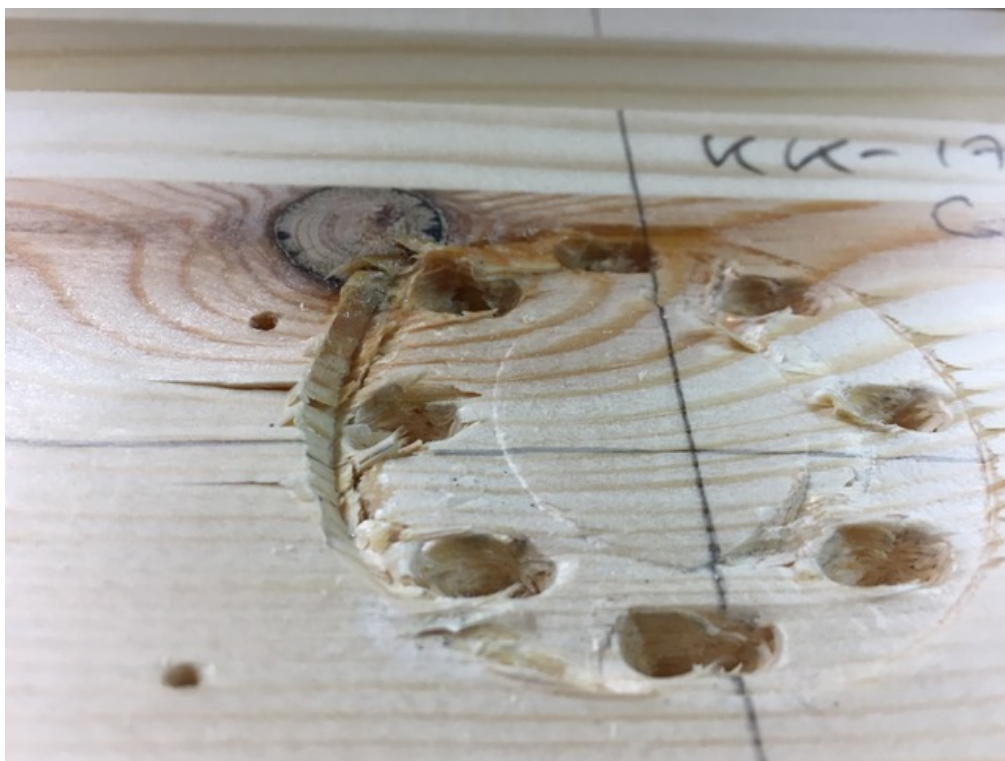
Joonis L4.14. Katsekehale KK17-C10/50 tekkinud hammastüübli jäljend
