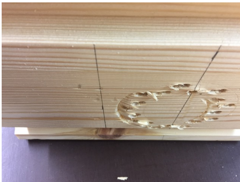
Joonis L3.16. Katsekehale KK8-C10/80 tekkinud hammastüübli jäljend
