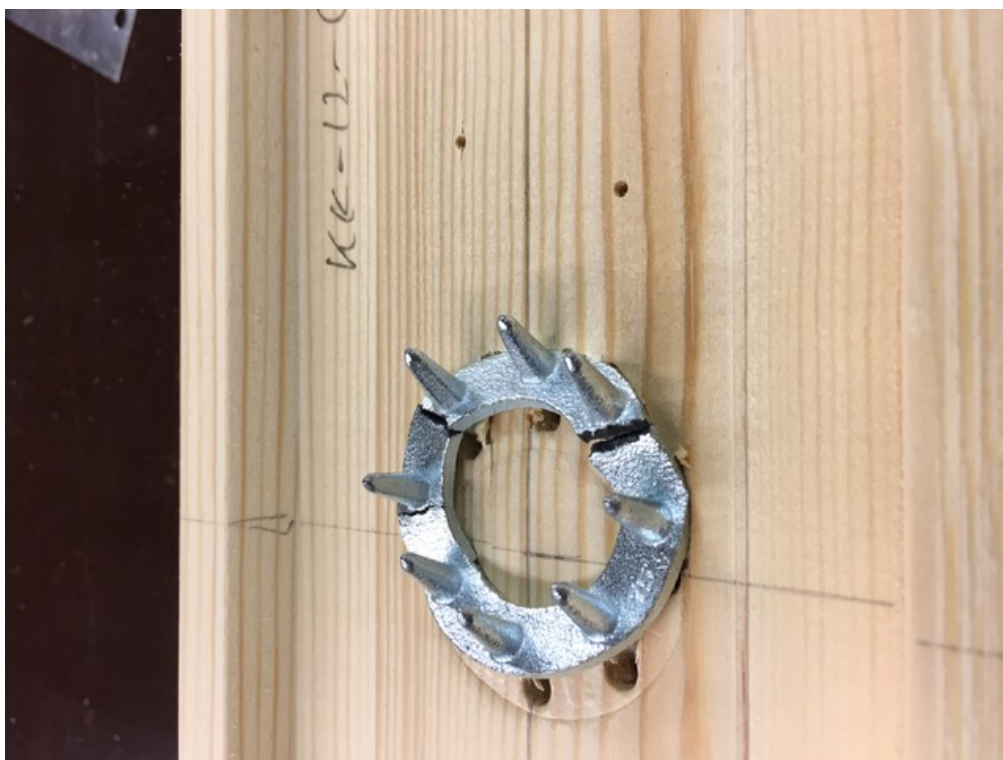
Joonis L4.3. Katsekeha KK12-C10/50 hammastüübli purunemine
