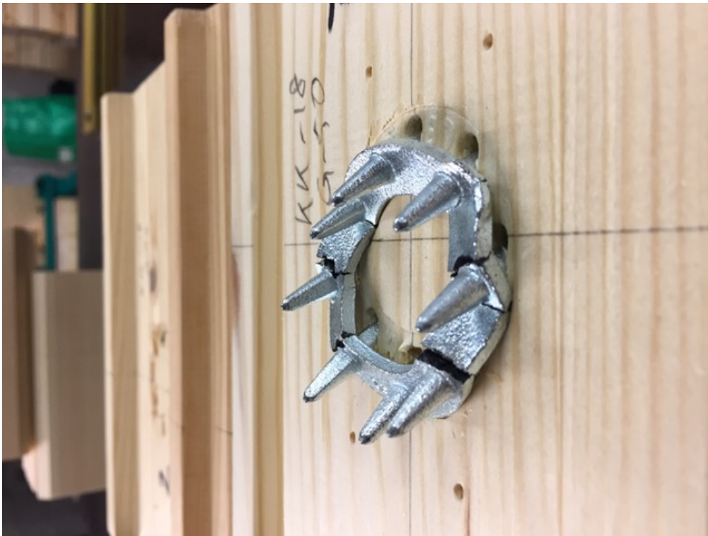
Joonis L4.15. Katsekeha KK18-C10/50 hammastüübli purunemine
