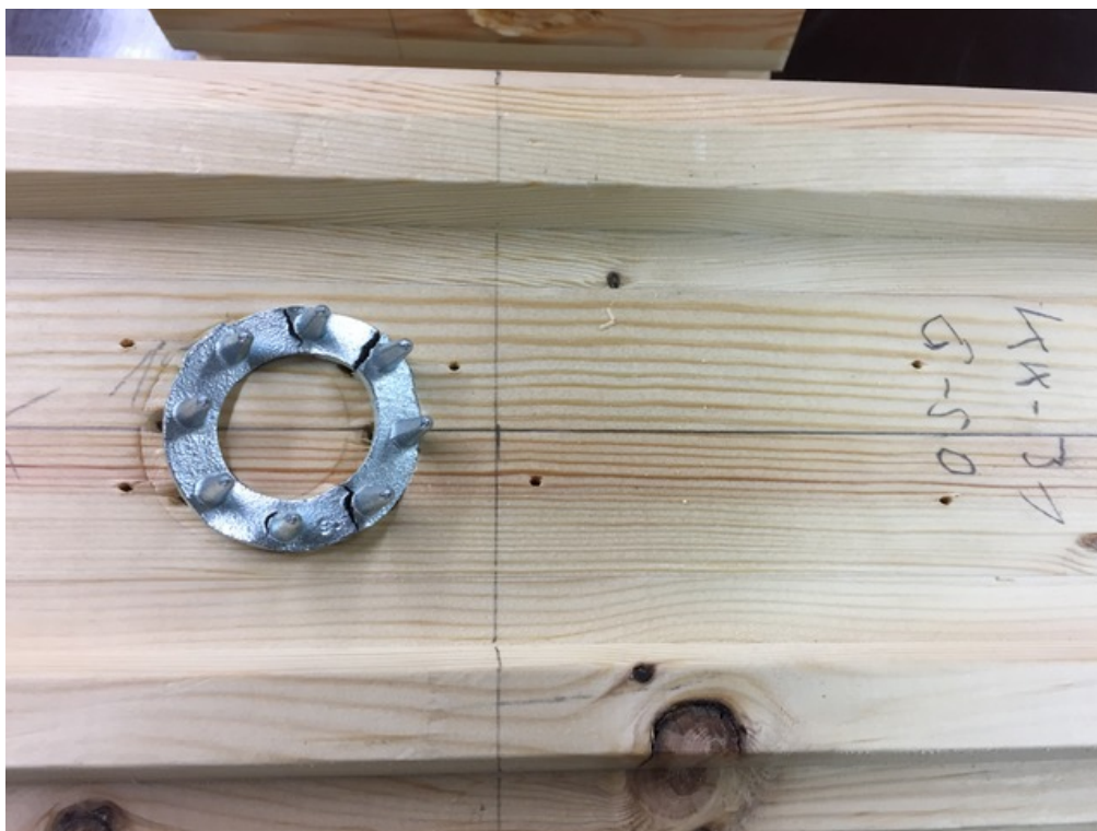
Joonis L6.1. Katsekeha KK31-2xC10/50 hammastüübli purunemine
