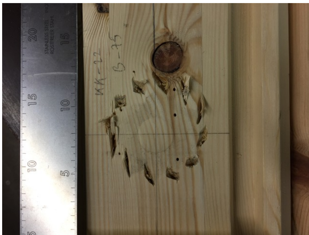
Joonis L5.4. Katsekehale KK22-C1/75 tekkinud hammastüübli jäljend
