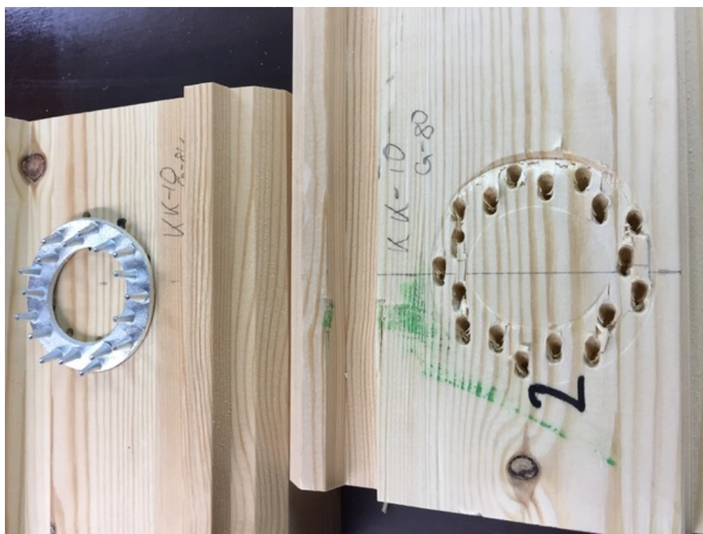
Joonis L3.20. Katsekehale KK10-C10/80 tekkinud hammastüübli jäljend
