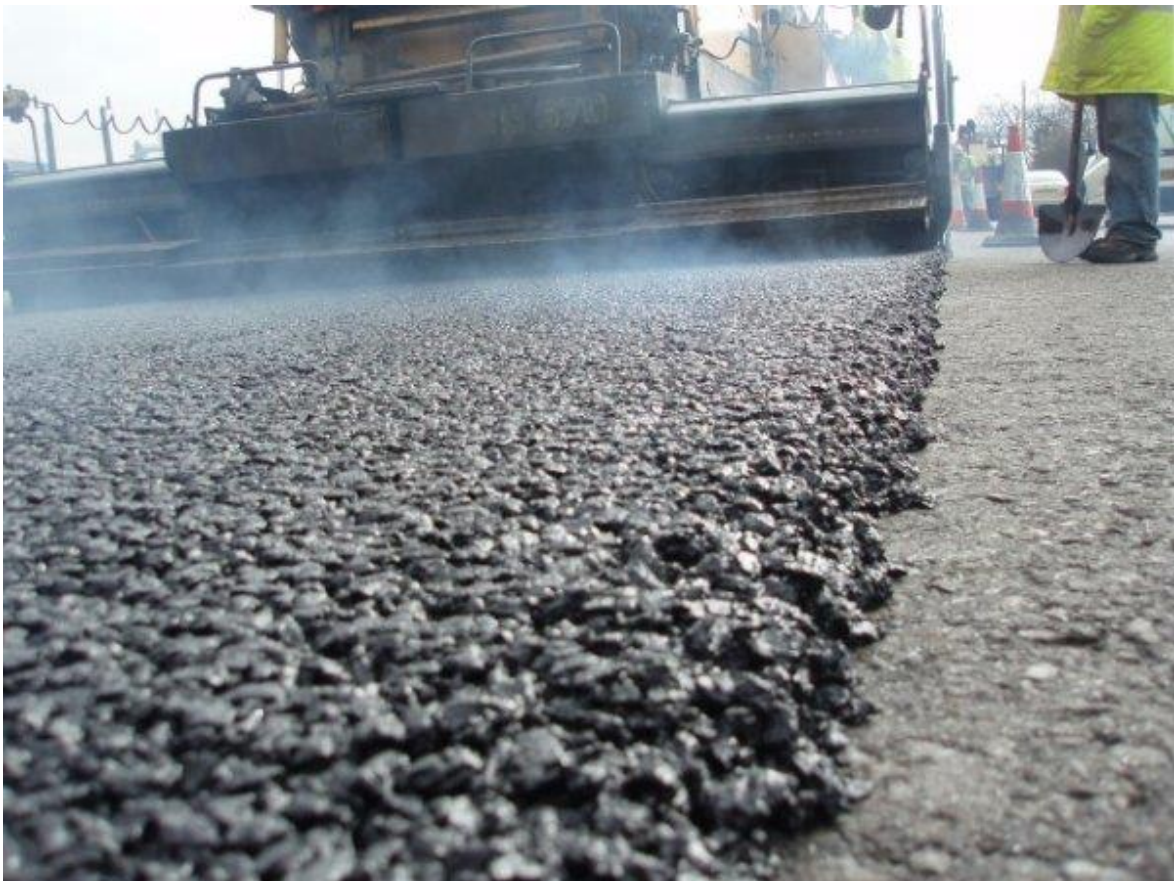
Joonis 10. Asfaldi laotamine (Balticfloc 2017).
