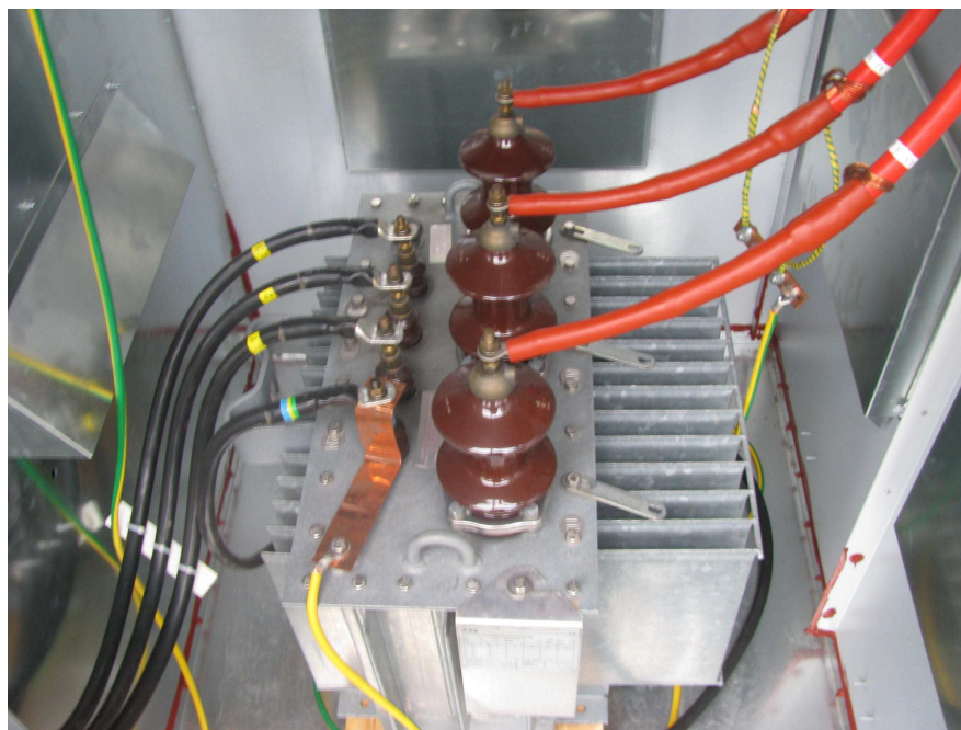
Joonis 4.2. ABB 10/0,4 kV õlitrafo 50 kV·A [2]
