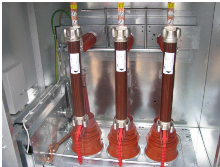
Joonis 4.3. Keskpingseseade AREVA ISARC I_n=400 A, U_r=24 kV, I_k=20 kA [2]
