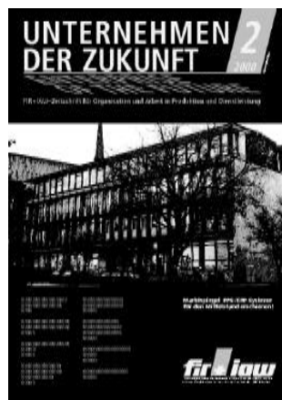
Das Titelbild zeigt das FIR-Gebäude nach der Aufstockung um eine weitere Etage im Januar 2000. (siehe auch Artikel Seite 17)
