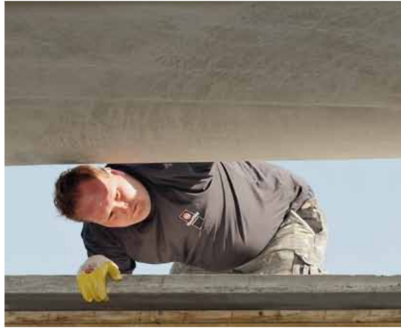
Bild 4/5: Umsetzen der vierten Textilbetonschale mit einem Autokran auf die Stütze. Fotos: Peter Winandy
