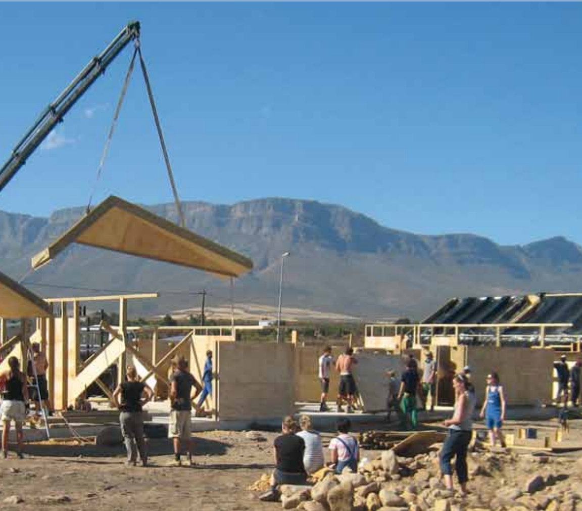
Bild 1: Studierende der RWTH Aachen bauen gemeinsam mit Einheimischen einen Kindergarten in Hamlet Creche, Afrika.
