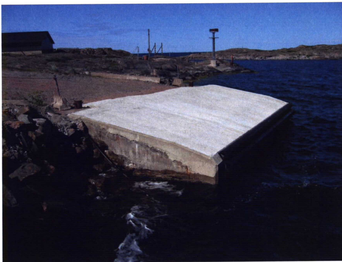
Kuva 8. Betoniset massiivilaiturit voivat olla rakenteeltaan huomattavasti kevyempiä (Utön laiturin keulaporttipaikka).
