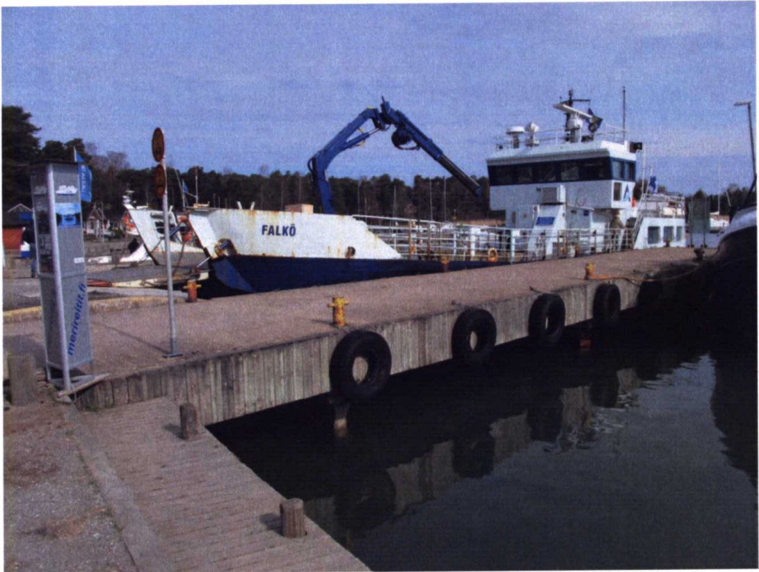
Kuva 6. Teräs- ja teräsbetonisten pystypaalujen päälle rakennettu suurelementtilaituri. Yhteysalus ms Falkö kiinnittyneenä laituriin (Nauvon kirkonkylän laituri).
