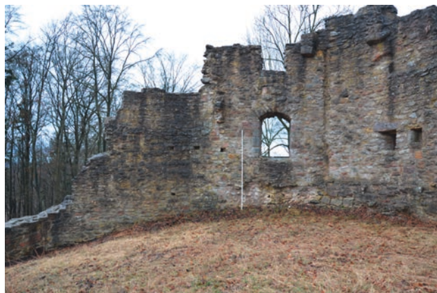
Abb. 144 Burgruine Henneberg, Ringmauer, Abschnitte sR-1 und wR-1 von Nordosten (Aufnahme 2013)
