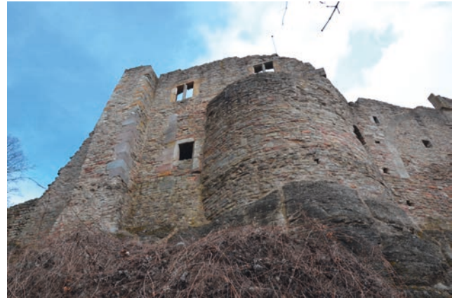
Abb. 150 Burgruine Henneberg, Ringmauer, Abschnitt wR-8 von Westen (Aufnahme 2013)
