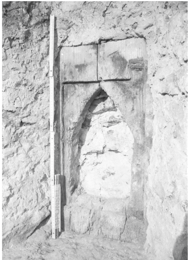
Abb. 148 Burgruine Henneberg, der hölzerne Fensterrahmen im Ringmauerabschnitt wR-7 (Aufnahme 1992)
