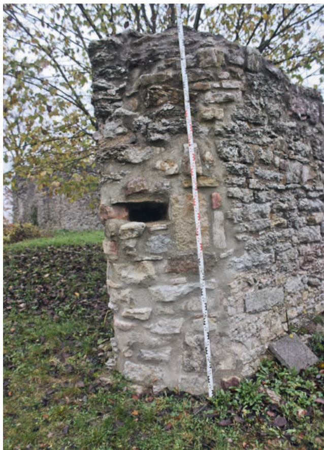
Abb. 120 Der Anschlag des spätmittelalterlichen Torriegels ist heute noch vorhanden (Aufnahme 2014)
