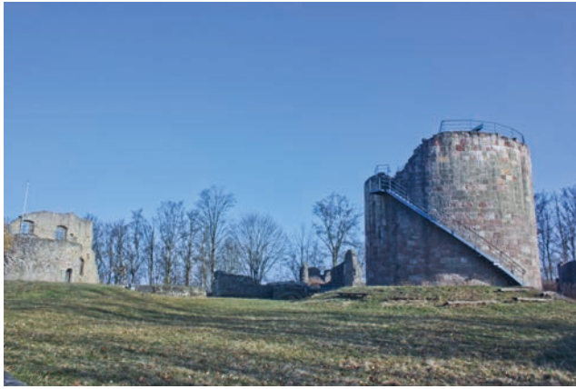
Abb. 110 Der Bergfried 2 nach der Sanierung, Ansicht von Südwesten (Aufnahme 2014)
