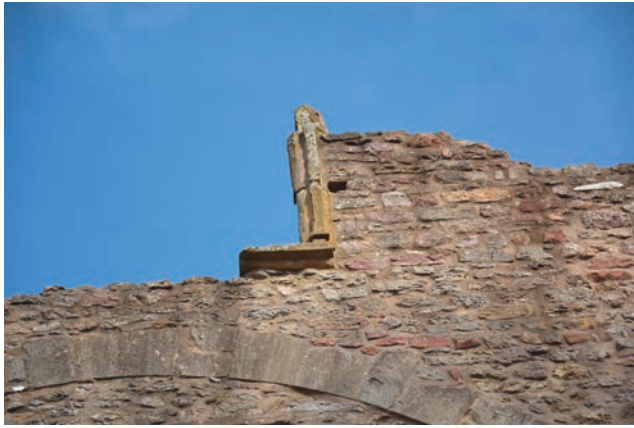
Abb. 149 Burgruine Henneberg, Ringmauer, Abschnitt wR-7, Gewändefragment des 1872 abgegangenen frühgotischen Gruppenfensters von Westen (Aufnahme 2013)
