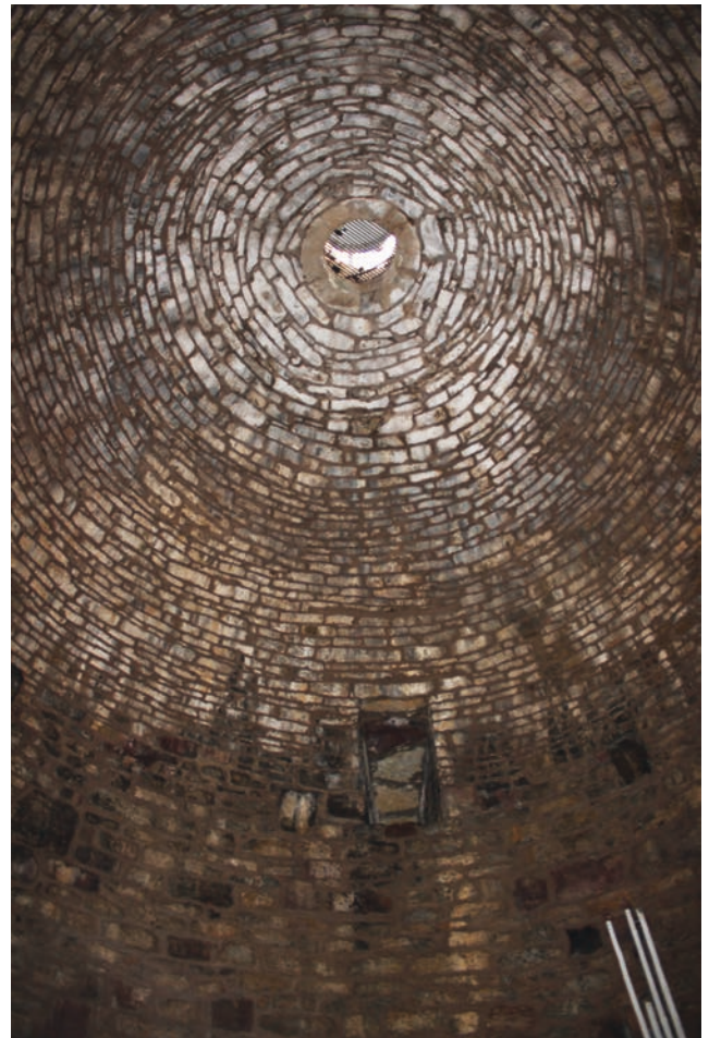
Abb. 154 Burgruine Henneberg, Bergfried, Untergeschoss, Gewölbe von Osten (Blick von unten) (Aufnahme 2013)
