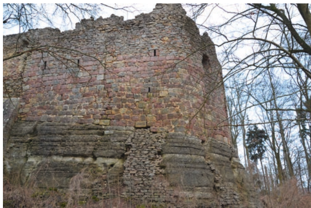
Abb. 143 Burgruine Henneberg, Ringmauer, Abschnitt wR-1 von Westen (Aufnahme 2013)
