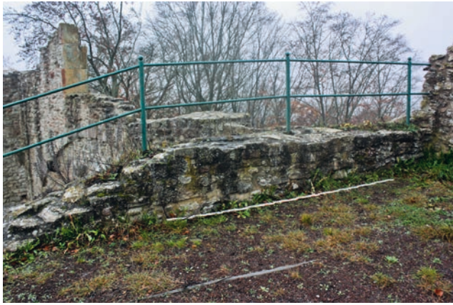
Abb. 117 In die Südwand des spätmittelalterlichen Wohnbaus aus dem 15. Jh. wurde der abgebrochene Turmrest integriert (Aufnahme 2014)
