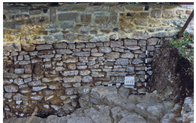
Abb. 84 Die am Plateaurand liegende Torwange eines Zangentores war ursprünglich wesentlich länger. Das Plateau ist im Spätmittelalter in diesem Bereich stark verändert worden (Aufnahme 1992)
