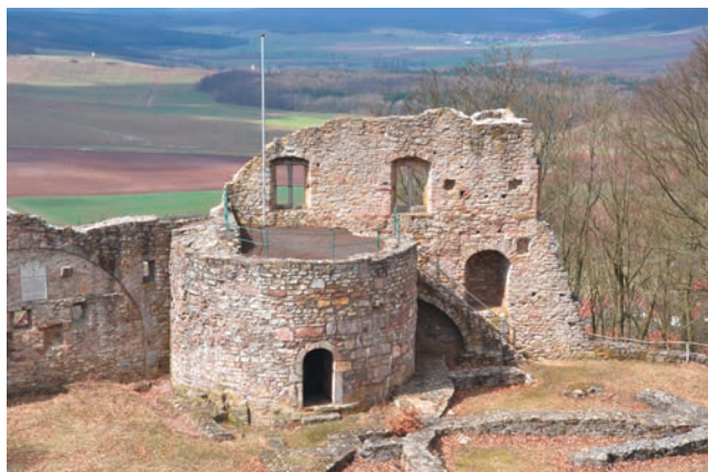
Abb. 151 Burgruine Henneberg, Ringmauer, Abschnitt wR-8 von Osten (Aufnahme 2013)
