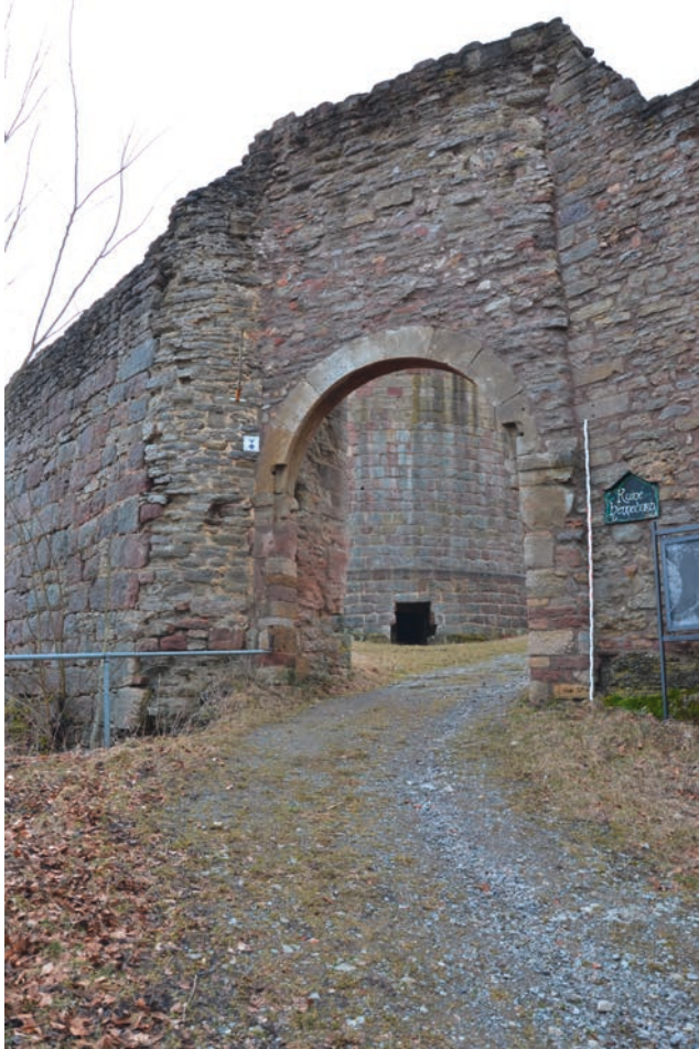
Abb. 138 Burgruine Henneberg, Ringmauer, Abschnitt öR-2 (Tor) von Nordosten (Aufnahme 2013)
