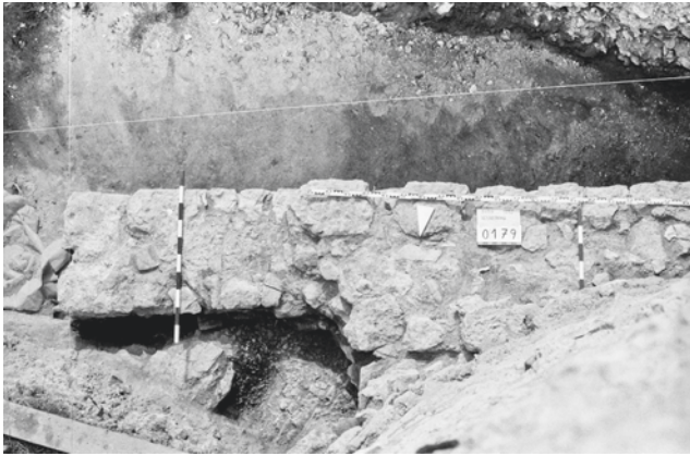
Abb. 99 Die Nordmauer der Holzstube wurde an den bereits stehenden Rundturm angebaut (Aufnahme 1993)
