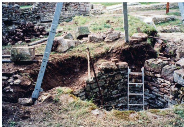
Abb. 121 Der Brunnen wurde 1996 bis zu einer Tiefe von 12,80 m entleert
