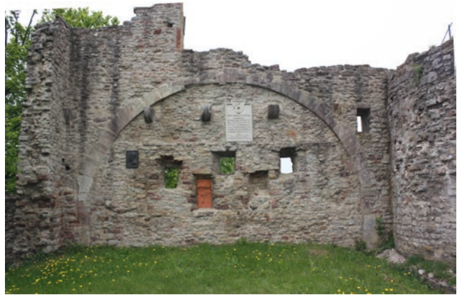
Abb. 147 Burgruine Henneberg, Ringmauer, Abschnitt wR-7 von Osten. Orange markiert der ursprüngliche Sitz eines herausgenommenen hölzernen Fensterrahmens (Aufnahme 2013)
