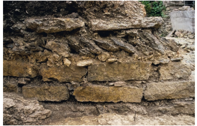
Abb. 72 Das Füllmauerwerk war teils im Opus spicatum ausgeführt (Aufnahme 2001)
