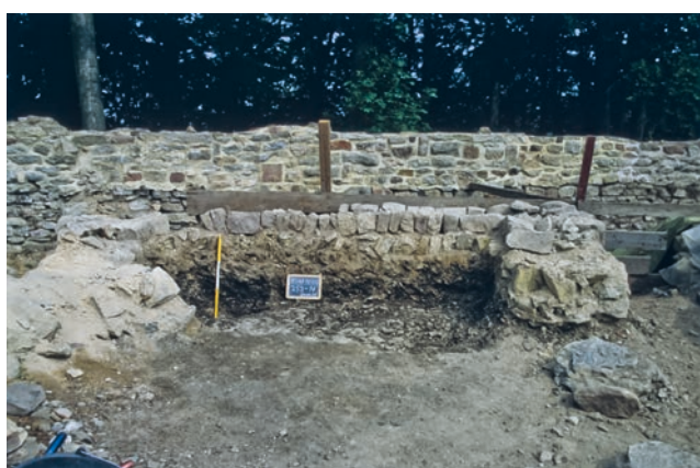
Abb. 68 Das Schalenmauerwerk aus Muschelkalk- und Buntsandsteinen gehört zu dem 3,80 × 3,00 m großen Gebäude VI, wohl ein Turm (Aufnahme 1995)
