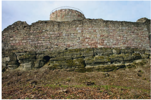
Abb. 85 Im Spätmittelalter wurde das Felsplateau steiler abgetragen (Aufnahme 2004)
