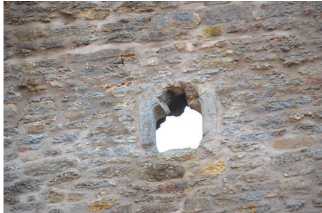
Abb. 137 Burgruine Henneberg, Ringmauer, Abschnitt nR-2, sekundär verbautes romanisches Fenstergewände von Norden (Aufnahme 2013)
