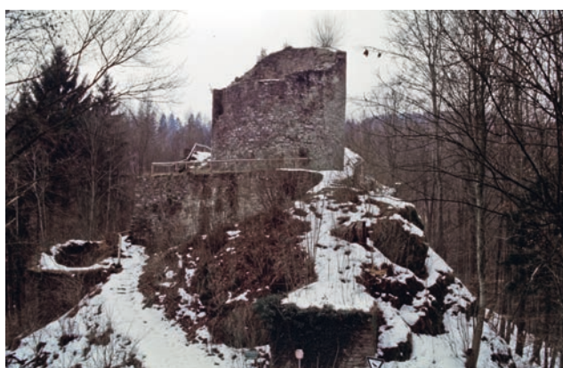
Abb. 78 Der Burgturm der Ruine Nordeck bei Stadtsteinach, Lkr. Kulmbach, hat einen Außendurchmesser von 10,68 m (Aufnahme 2003)
