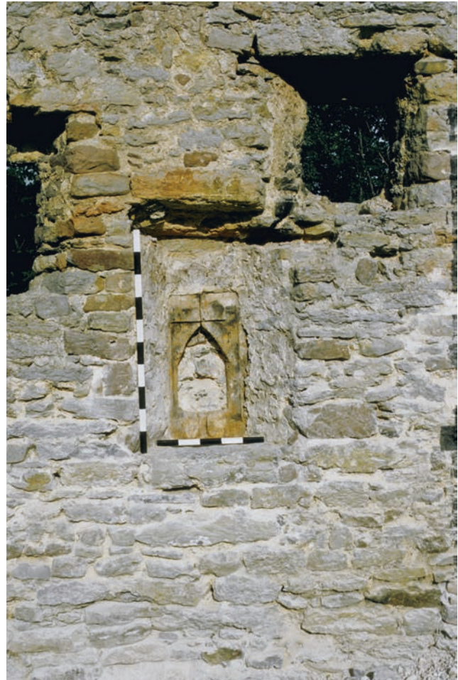
Abb. 101 In der Westwand der Holzstube war bis 1992 noch ein Holzrahmen verbaut. Er datiert auf um 1295 (Aufnahme 1992)
