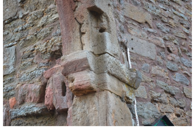
Abb. 139 Burgruine Henneberg, Ringmauer, Abschnitt öR-2 (Tor), nördliche Kämpferzone von Südosten (Aufnahme 2013)
