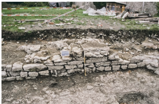
Abb. 64 Vom hochmittelalterlichen Wohnturm (Gebäude IV) konnte das nördliche Mauerfundament dokumentiert werden. Es bestand aus kleinteiligem Kalksteinquadermauerwerk (Aufnahme 1995)
