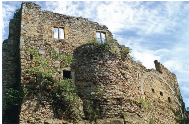
Abb. 86 Der Rundturm ragt aus der Mauerflucht heraus (Aufnahme 1990/1991)
