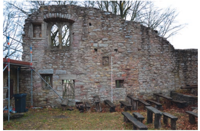
Abb. 146 Burgruine Henneberg, Ringmauer, Abschnitt wR-5 von Osten (Aufnahme 2013)
