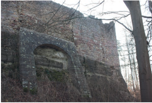
Abb. 19 Die im 19. Jh. erbauten Strebepfeiler sind noch gut sichtbar (Aufnahme 2014)
