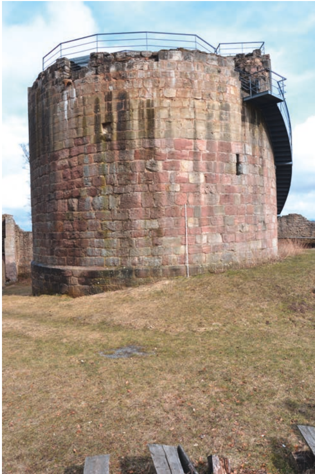
Abb. 152 Burgruine Henneberg, Bergfried von Westen (Aufnahme 2013)
