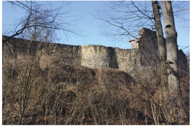
Abb. 34 Bei der Sanierung der südlichen Ringmauer ist das Halbrund des Turmes in die Mauer eingefügt worden (Aufnahme 2014)
