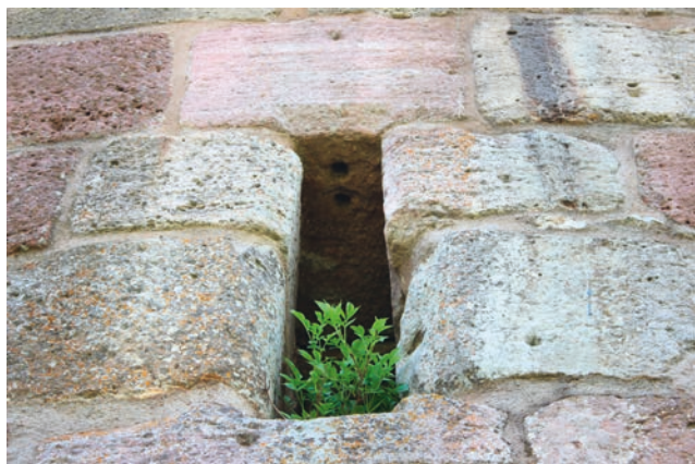
Abb. 155 Burgruine Henneberg, Bergfried, Schlitzfenster von Westen. Die Dübellöcher verweisen auf eine Vergitterung (Aufnahme 2013)
