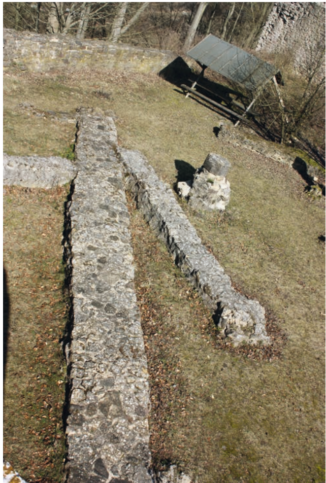
Abb. 31 Bei der Sanierung 1995 wurde der nördliche Abschluss des Wohnbaus (Palas) nicht mit ausgeführt, Ansicht von Süden (Aufnahme 2014)
