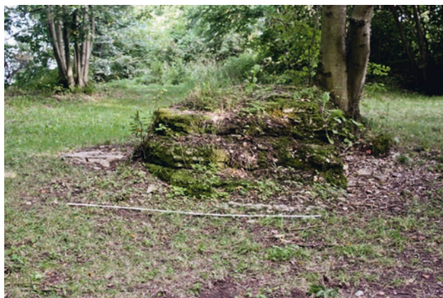
Abb. 112 Im ehemaligen Zwinger sind Fundamentreste zu sehen, die zu einer Kemenate gehörten (Aufnahme 2014)
