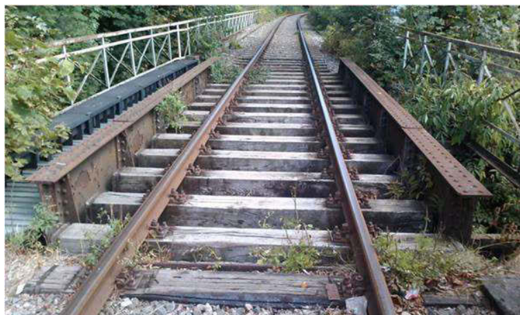
Abb. 5.36: Beispiel der Balkenbrücke
