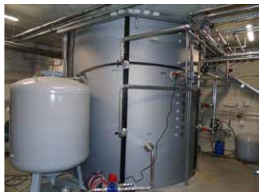
Abbildung 4: Großpufferspeicher (31 m 3 )
