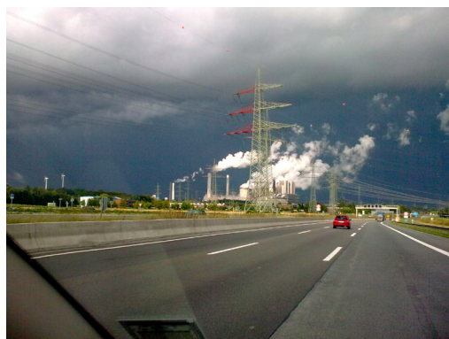
links Abb. 20: fossile Energiegewinnung im RWE-Braunkohlekraftwerk in Weisweiler
