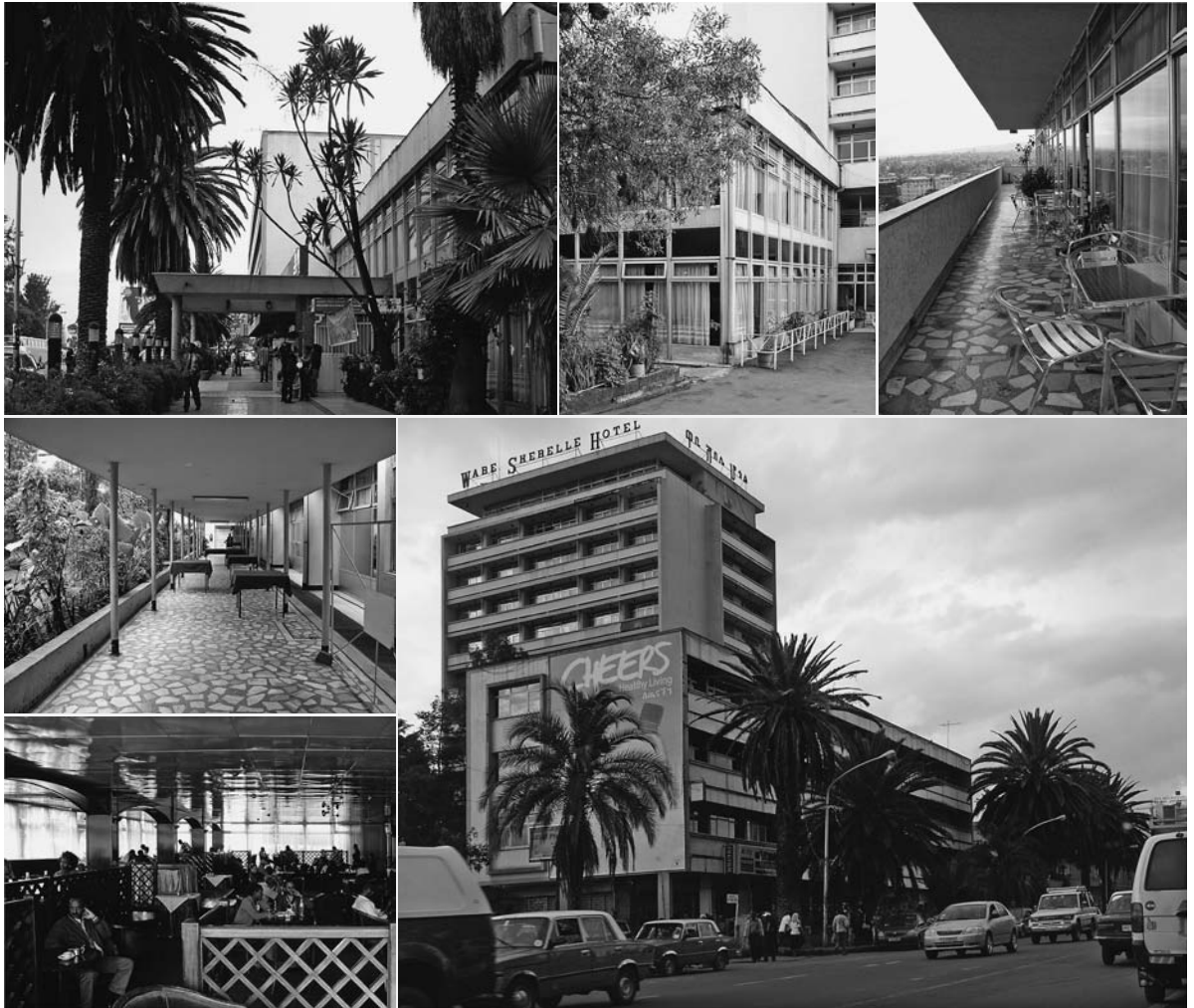
FIG. 1 B. PETROVIĆ, WABE SHEBELLE HOTEL, ADDIS ABABA, ETHIOPIA, 1968: PHOTO COLLAGE OF THE BUILDING'S DIVERSE ARCHITECTURAL AND URBAN SEQUENCES SL. 1. B. PETROVIĆ: HOTEL WABE SHEBELLE, ADDIS ABABA, ETIOPIJA, 1968. FOTOKOLAŽ RAZLIČITIH ARHITEKTONSKO-URBANISTIČKIH SEKVENCI ZGRADE
