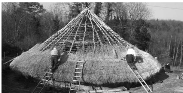
Figura 36b. Cobrindo o telhado da rondhouse da Idade do Ferro, no Chiltern Open Air Museum.
