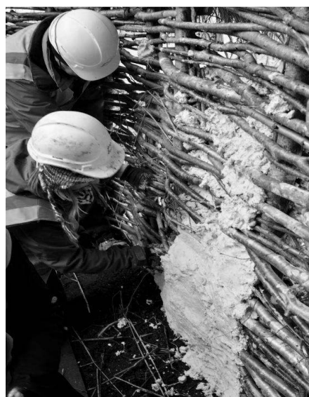
Figura 23. Aplicação do adobe entre o entrelaçado de ramos de aveleira, pela equipa que reconstituiu as casas neolíticas de Stonehenge. O adobe foi aplicado em simultâneo pelo exterior e pelo interior, de modo a ficar compacto e a formar uma parede consistente.
