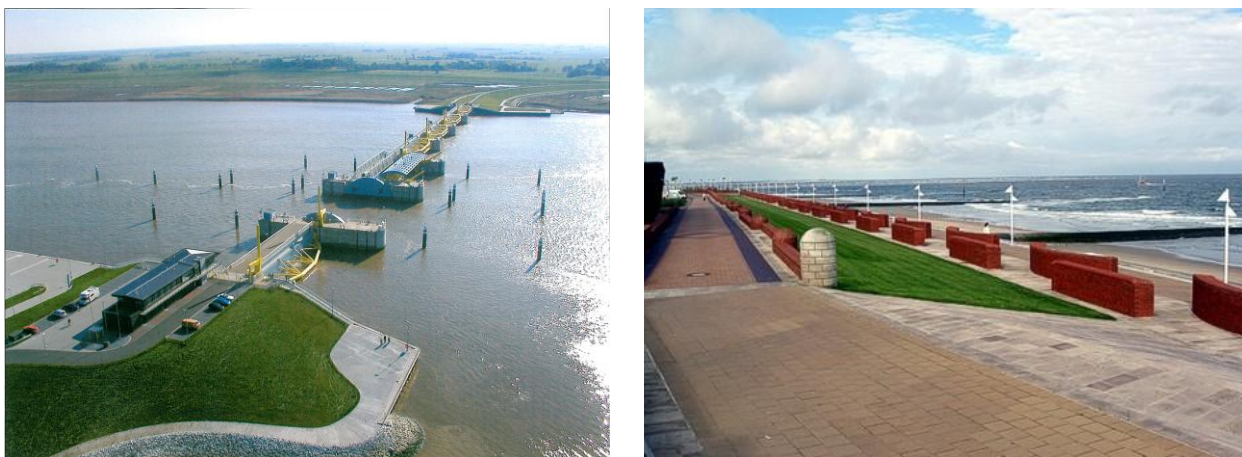
Abbildung 1: links: Emssperrwerk; rechts: Schwall- und Kronenmauern auf Norderney (Quelle: NLWKN)
