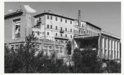
Ex lanificio Carotti post crollo
