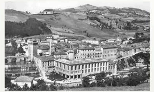
Ex lanificio Carotti pre-crollo
