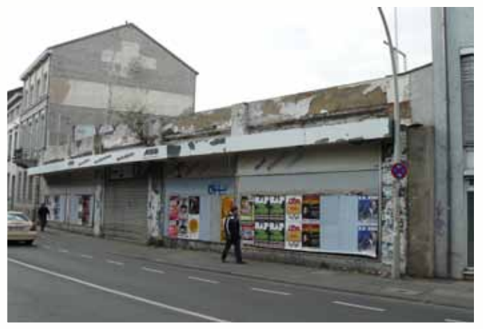
Baulücke an der Bornheimer Straße
