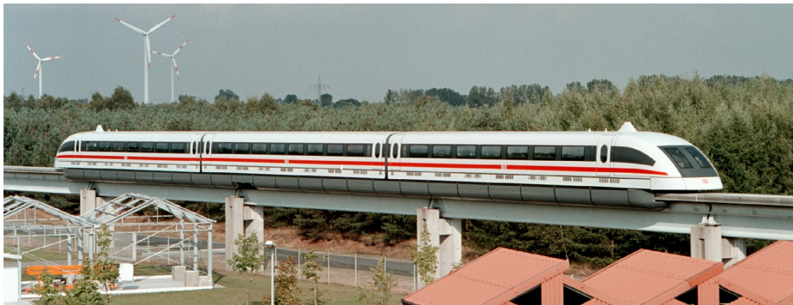
Bild 8.8: Die Magnetschwebebahn Transrapid auf der Versuchsstrecke in Lathen, Emsland (aus Transrapid (2002)).
