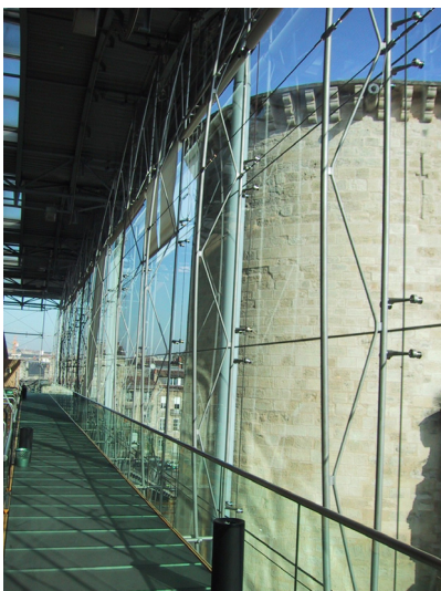
Bild 1.1: Fassaden- und Brüstungsverglasung des Tribunal de Grande Instance Bordeaux (F) (links), Fassaden- und Dachverglasung Glashof Jüdisches Museum Berlin (rechts)
