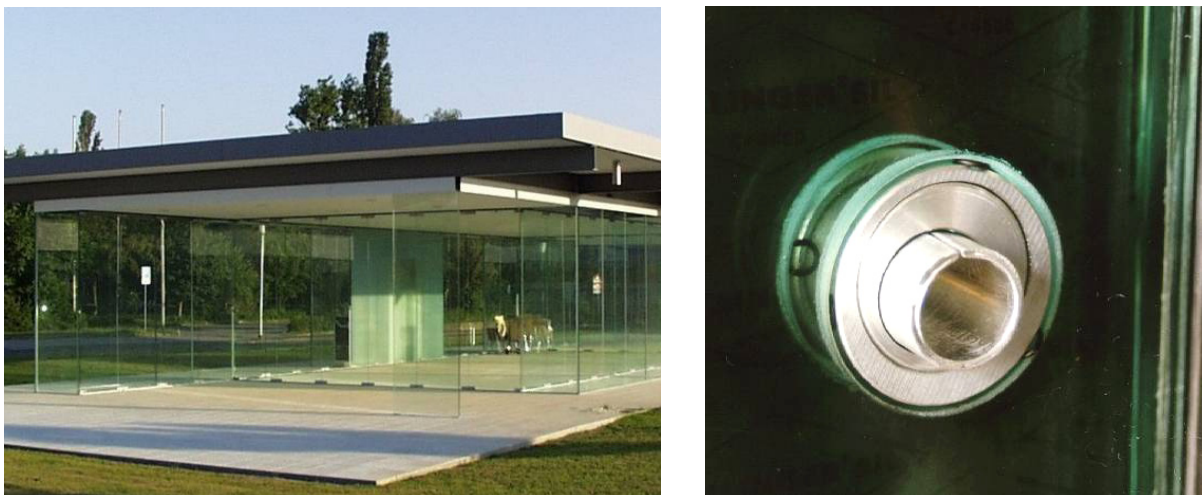
Bild 1.3: Pavillon der Sommerakademie in Rheinbach, Anschlussdetail SL-Verbindungen
