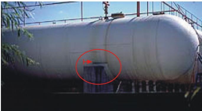
a) Horizontal verrutschter Flüssiggastank [67]
