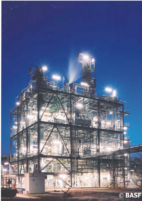
a) Stahlrahmen mit aussteifenden Diagonalen [87]
