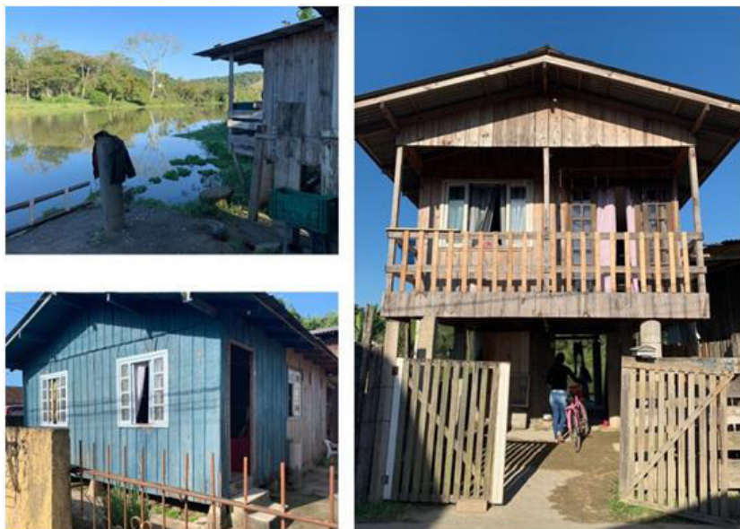
Figura 1: Residências existentes no Bairro Cidade Nova
