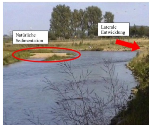
Abbildung B.15: Rur oberhalb des Schanzwehrs – Zustand nach Durchführung der Maßnahme (Ingenieurgesellschaft Dr. Ing. Nacken mbH, 2004)
