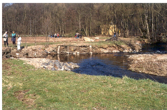
Abbildung B.7: eingegrabene Wurzelstöcke (LfU BW, 2002a)
