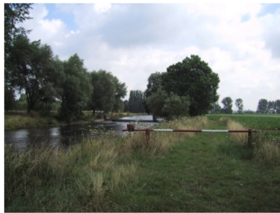
Abbildung B.14: Rur oberhalb des Schanzwehres – Zustand vor Durchführung der Maßnahme (Ingenieurgesellschaft Dr. Ing. Nacken mbH, 2004)
