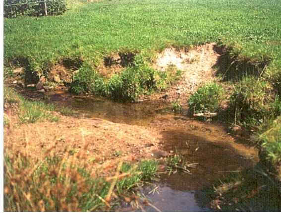
Abbildung B.6: Natürlicher Uferabbruch nach Einstellung der Gewässerunterhaltung (HMULV, 2007)
