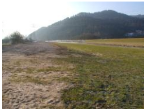
Abbildung B.20: Verdoppelung der Bettbreite durch Entfernung eines Vorlandes, Zustand vor der Baumaßnahme (Kinzig bei Biberach (Zollwehr)) (River-Consult, 2007)
