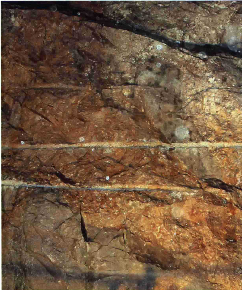
Kuva 17. Porareian puolikkaita Vuosaaren junaratatunnelin seinämässä.
