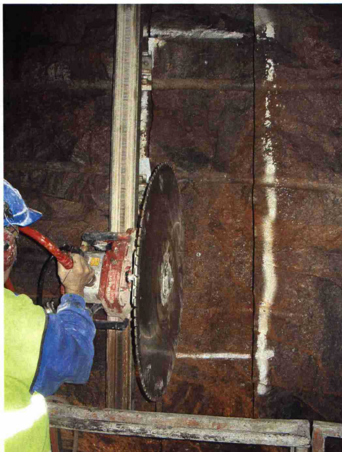
Kuva 27. Reunalinjat Kemiitti 810:llä panostetun testikatkon sahausen valmistelua, timanttiterän halkaisija on 600 mm.
