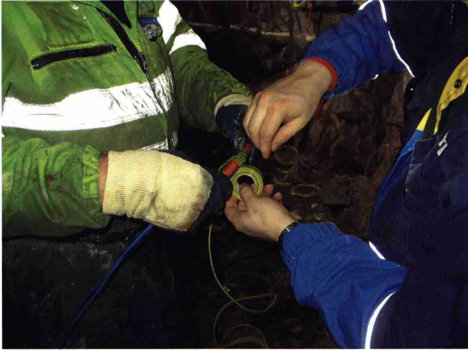
Kuva 22. Sinistä, oikosuljettua koaksiaalikaapelia kiinnitetään Nobel Prime räjäyttimeen.
