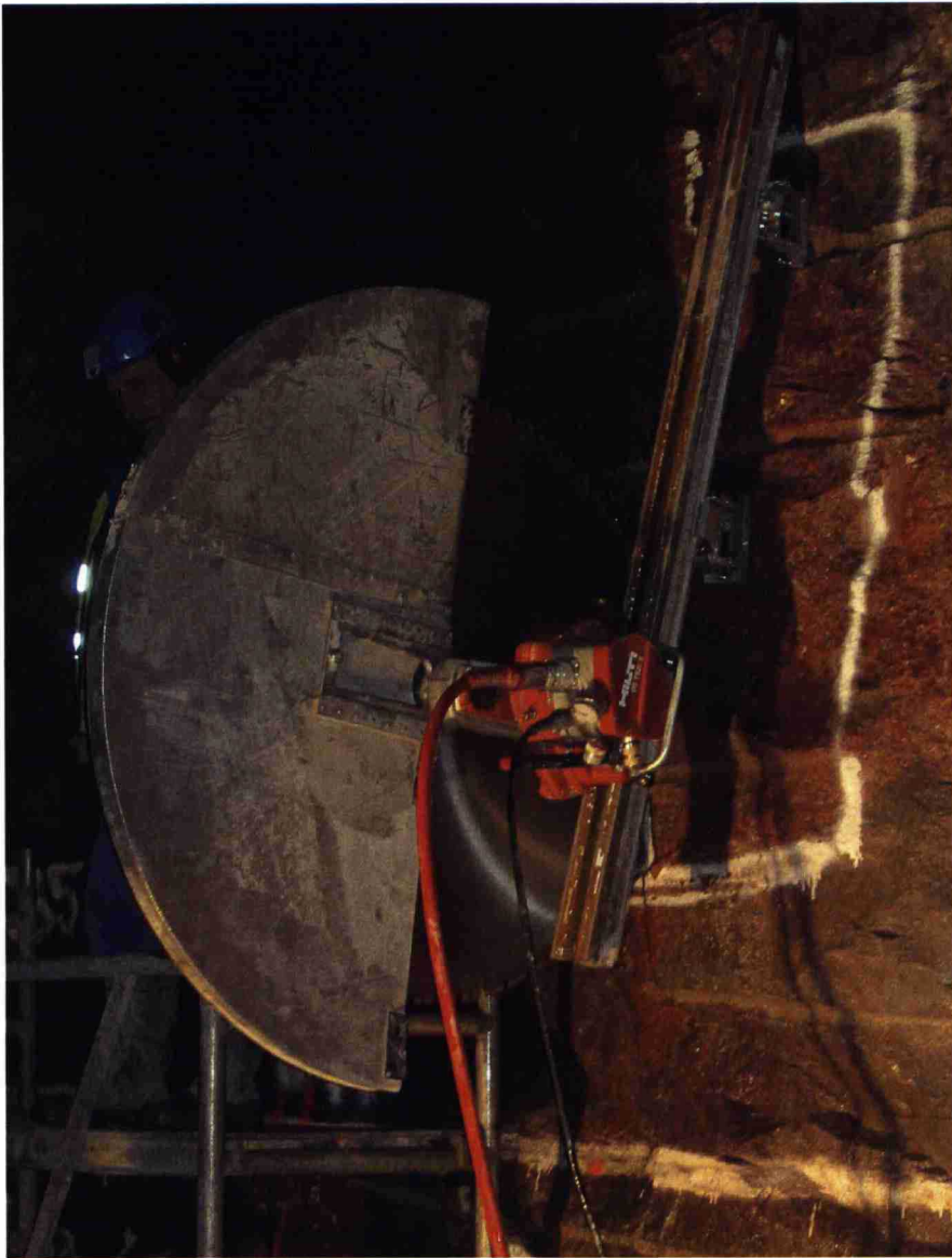
Kuva 28. Patruunoilla panostetun testikatkon sahaus jatkuu halkaisijaltaan 1200 mm terällä.
