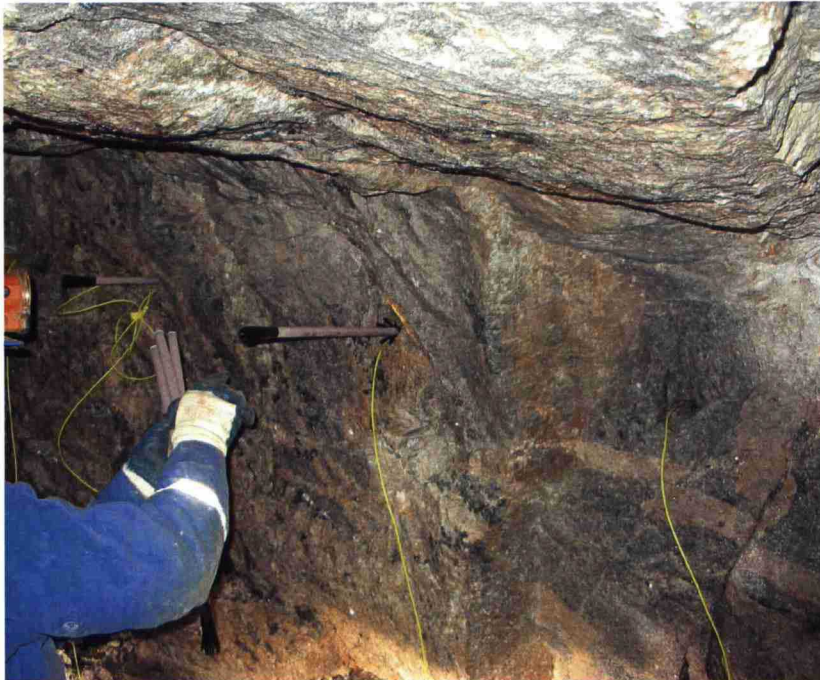
Kuva 26. 17 millimetrin F-putkia panostetaan reunalinjaan.
