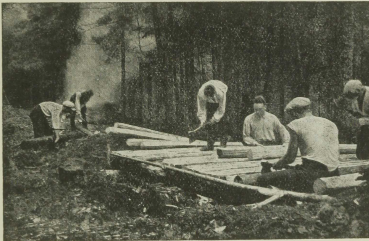
Trumbi ehitamine. — Construction d'un petit pont.
