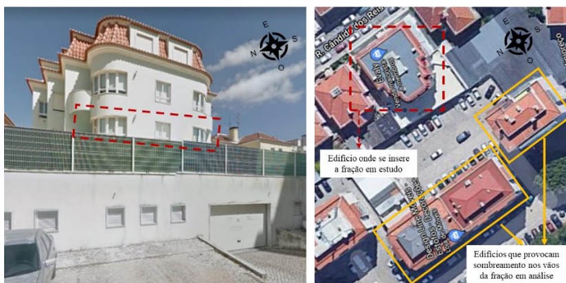
Figura 4.1 - Identificação da fração em estudo: fachada principal, orientada a oeste (esquerda) e imagem satélite (à direita)
