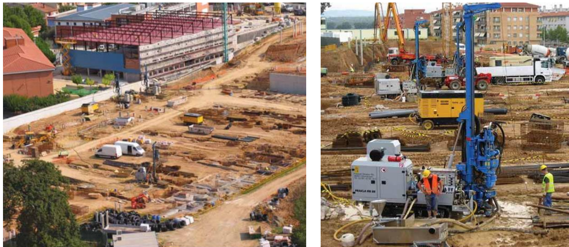
Figura 16: Instalación para la climatización con geotermia del nuevo Hospital de Mollet del Vallés
