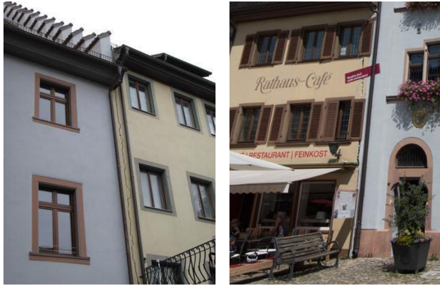
Daños en la localidad de Staufen producidos por la comunicación de un acuífero con capas de anhidrita debido a un mal sellado [76,77]
