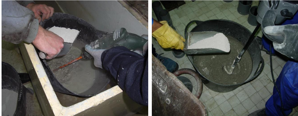
Figura 20: Amasada de los rellenos tipo G (izq.) y de los rellenos tipo M (dcha.)
