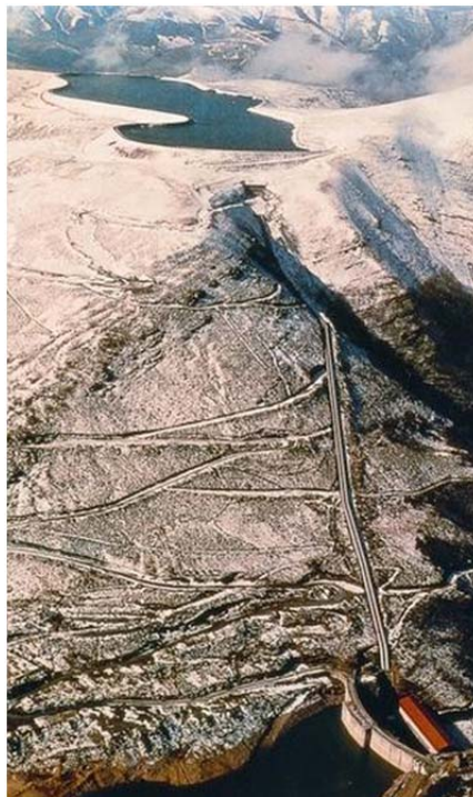
Figura 11. Vista de la central hidroeléctrica de Aguayo. Fuente: REPSOL
