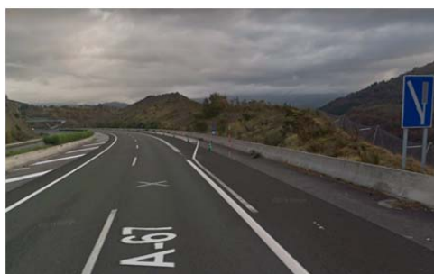
Figura 9. Entrada a la zona de frenado de emergencia
