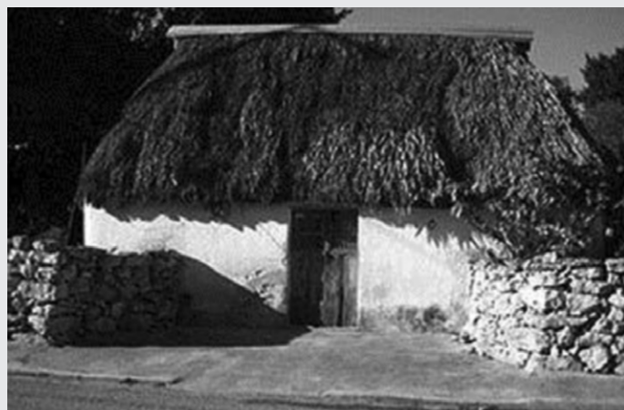
Figura 15. Casa Maya con muros de embarro en la región de Yucatán ( www.posadavienahotel.com/mexico44.htm ).
