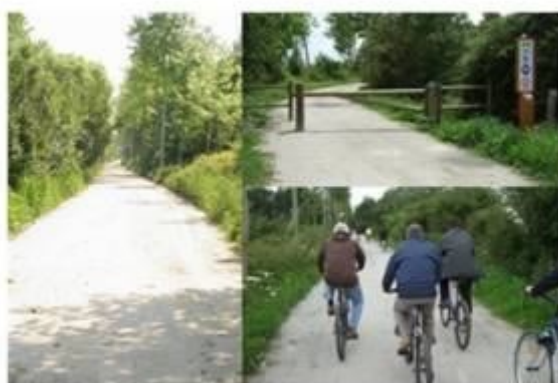
Figure 2.8 : Piste cyclable du Mont-Saint-Michel réalisée avec 70 000 m 3 de sédiments(Hayet et al.,2017)
