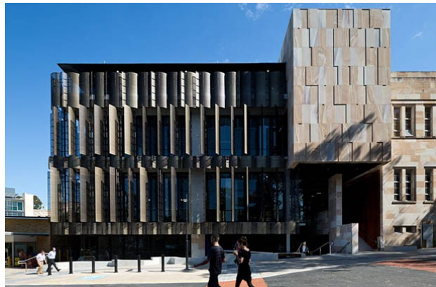
Figure 2.3 : Vue de l'Université de Queensland en Australie [4].
