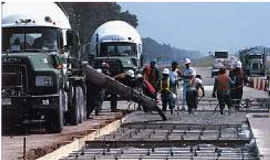
Figure 2.1 : Rénovation d'une route en utilisant le ciment PYRAMENT © [3].
